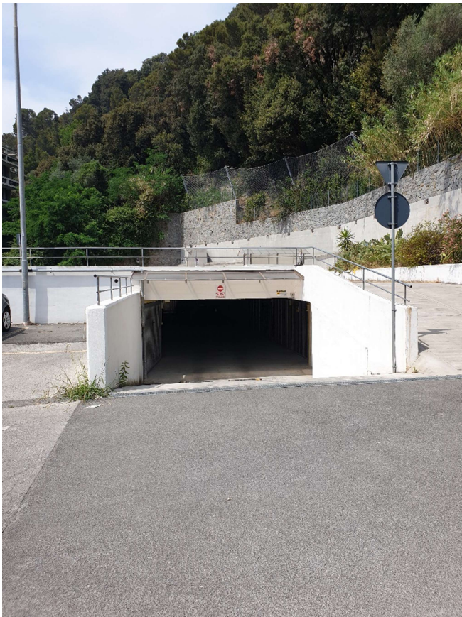
Accesso all'interno dell'autorimessa
