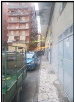
Foto n.1 fronte strada-viale Trieste
