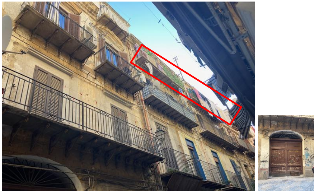
Prospetto e portone di ingresso condominiale su via Materassai, 51
