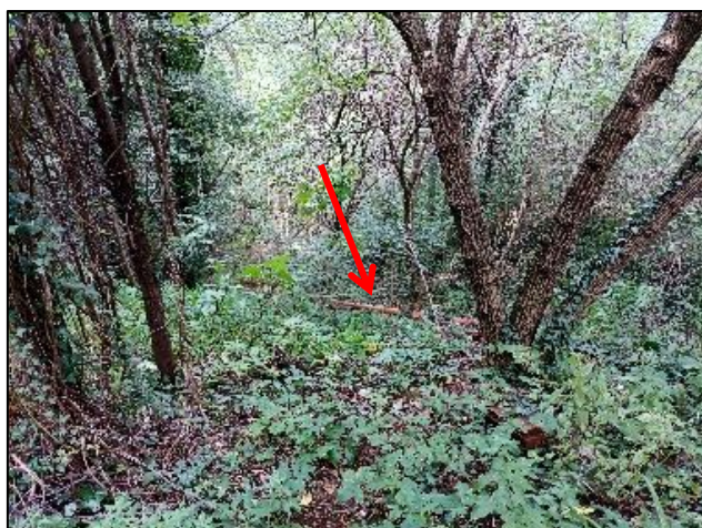
Tubazione di scarico all'interno del terreno
