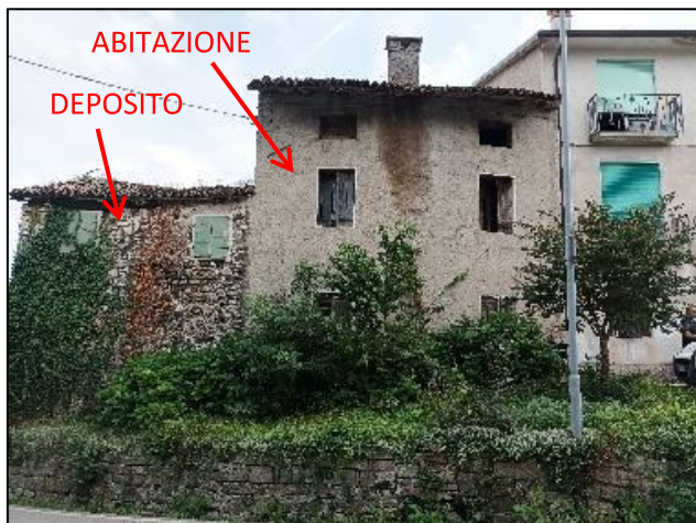
Facciata nord vista dalla strada
