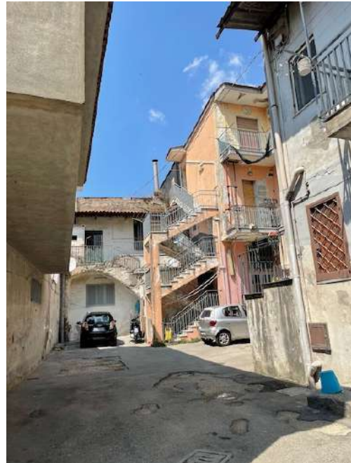
Fig. 2. Vista del cortile, del fabbricato e della scala.
