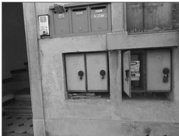
Dettaglio contatori gas, acqua ed energia elettrica
