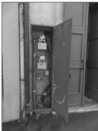
Dettaglio contatori gas, acqua ed energia elettrica
