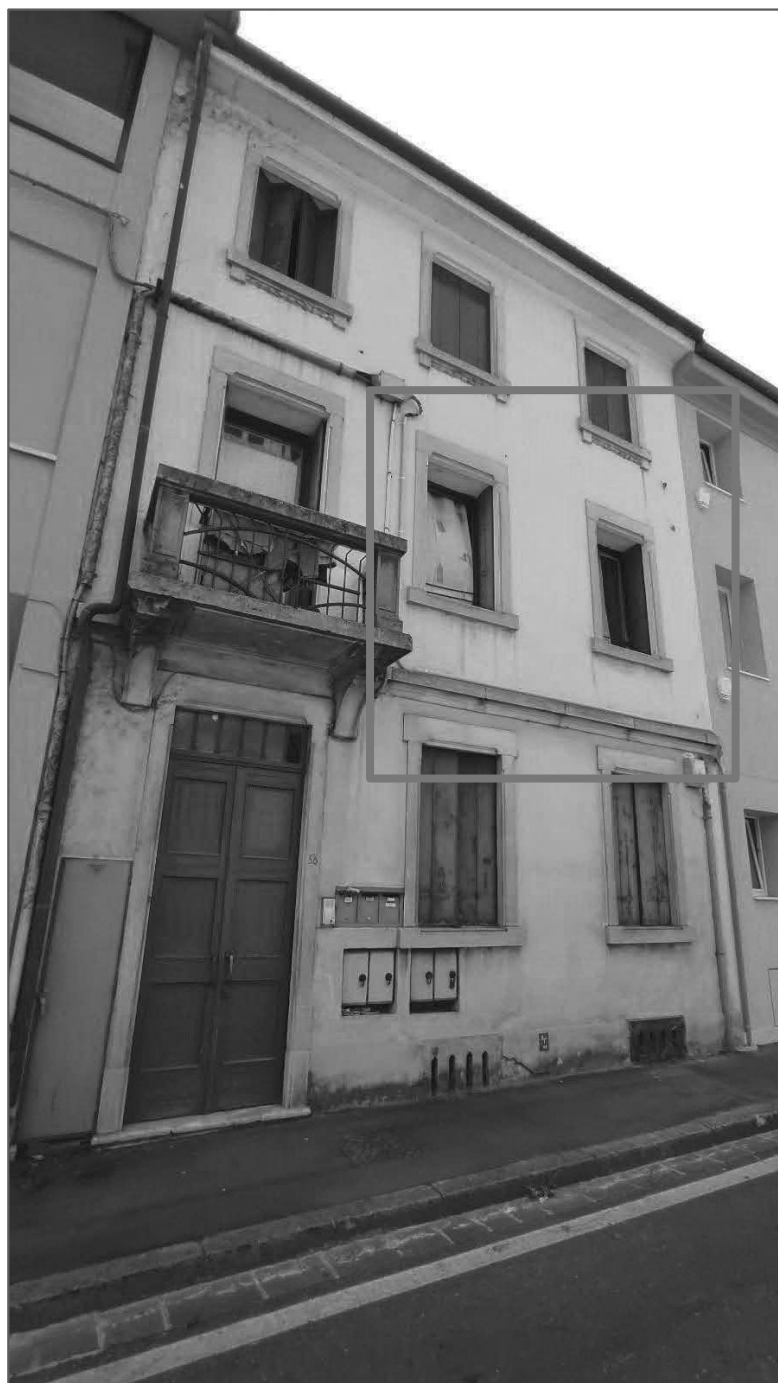
Prospetto nord/est, ingresso via Venezia, n° 56 appartamento piano primo
