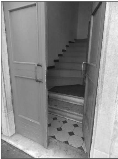
Particolare ingresso PT
