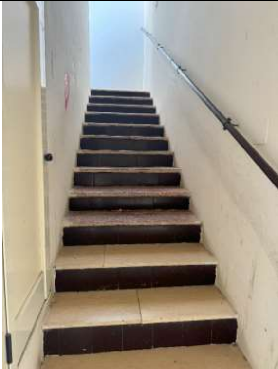
Foto 18 Scala di accesso al P1
