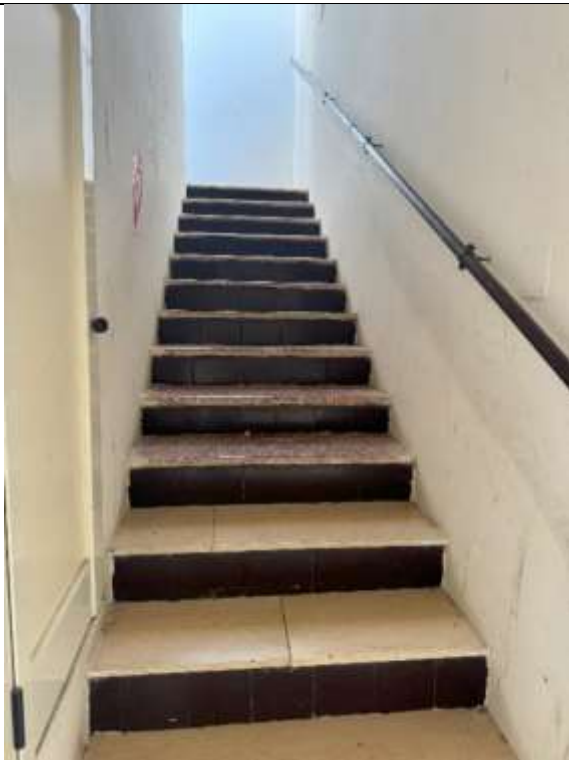
Foto 9 Scala di accesso al P1
