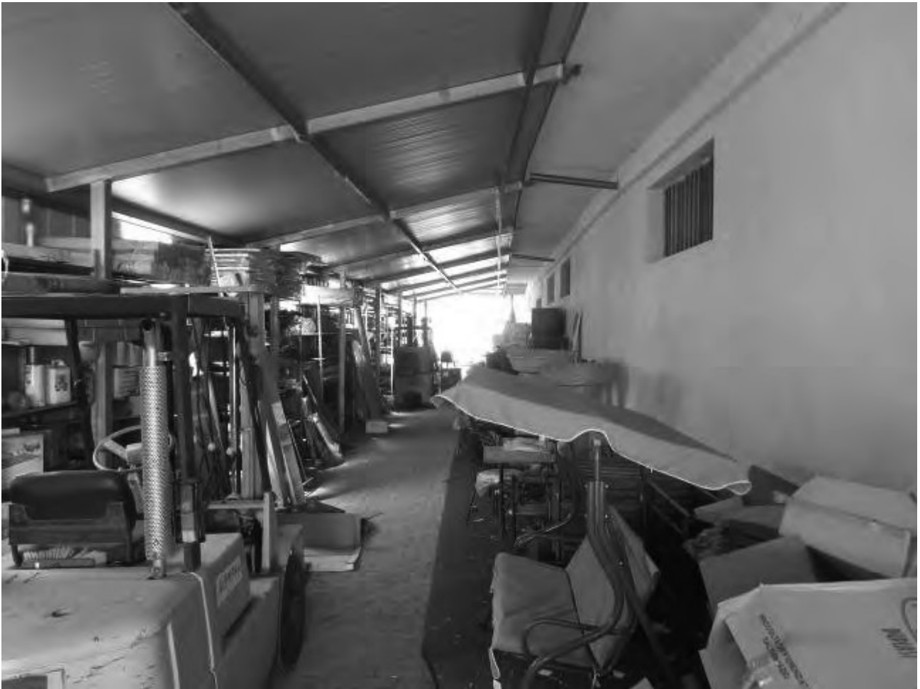
Foto n° 11: p.lla 113 – parete ovest sub 1102 – tettoia compresa nel sub 1101 (b.c.n.c.)
