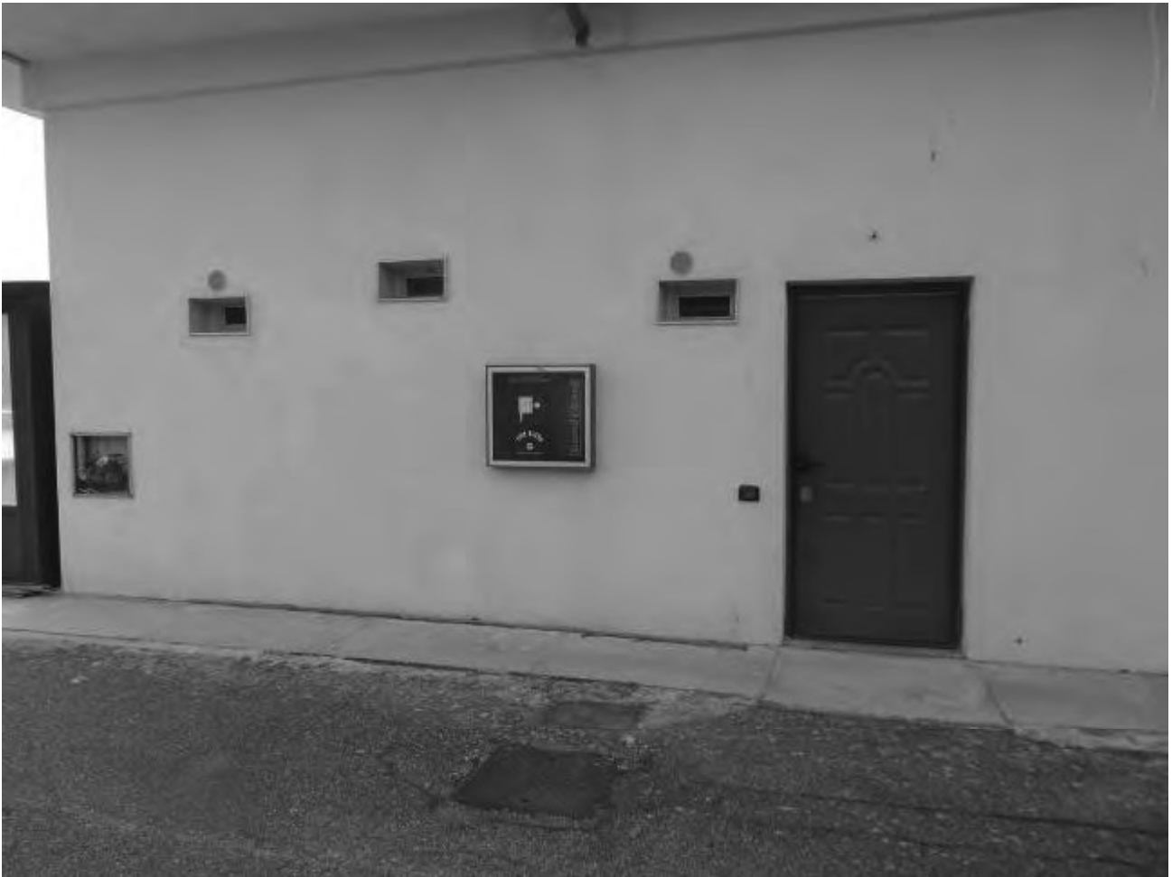
Foto n° 5: P.Ila 113 – accesso dipendenti dell'attività commerciale
