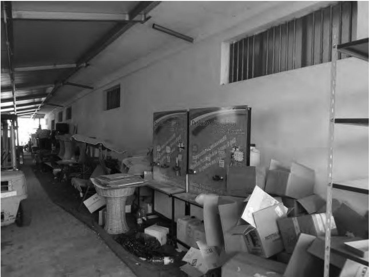
Foto n° 9: p.lla 113 – parete esterna sub 1102 – tettoia compresa nel sub 1101 (b.c.n.c.)
