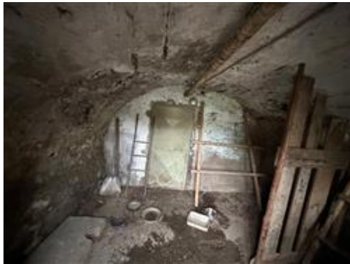
Locali a piano terra
