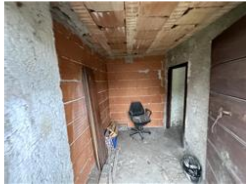
Locali a piano terra
