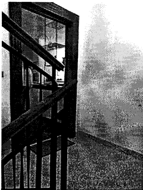
Ingresso all'alloggia dal vano scala
