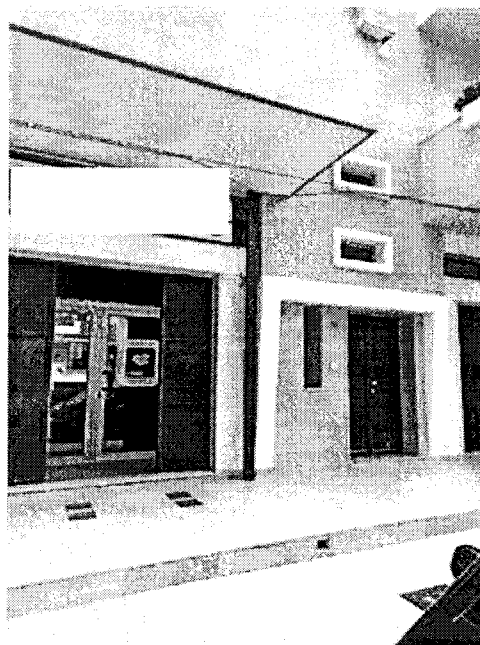
Vano scala, civ. 73 di viale indipendenza
