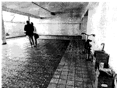
Vista area di manovra
