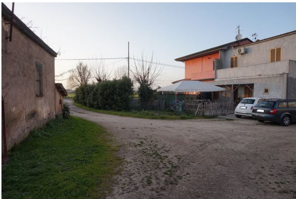
Foto 8 – Vista del viale in terra battuta di accesso all'area di sedime e dell'immobile pignorato
