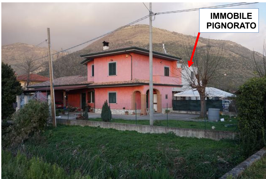
Foto 5 – Vista, dalla Via Tufette 18, dell'immobile pignorato
