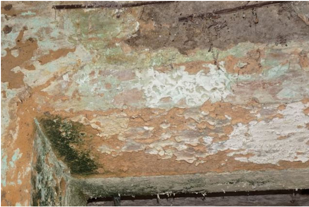
Foto 47– I muri esterni, interni e del solaio del manufatto
