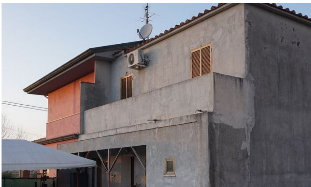
Foto 20 – Il piccolo portico da cui si accede al piano terra e al ripostiglio
