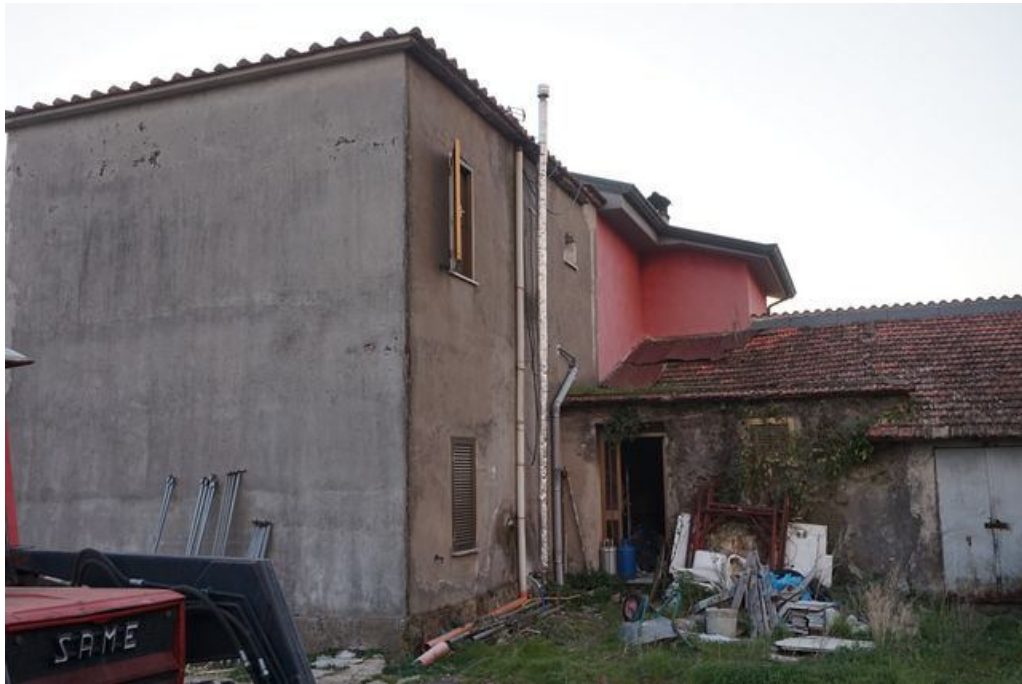
Foto 11 – Vista posteriore del bene pignorato, costituito dall'unità residenziale e del manufatto ad essa adiacente
