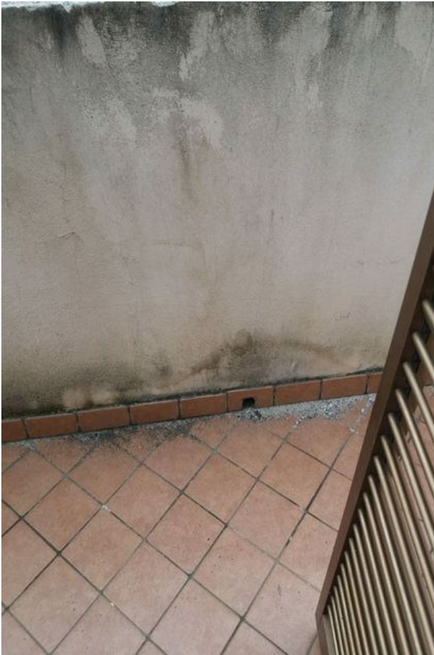
Foto 35 – Vista del balcone del piano primo
