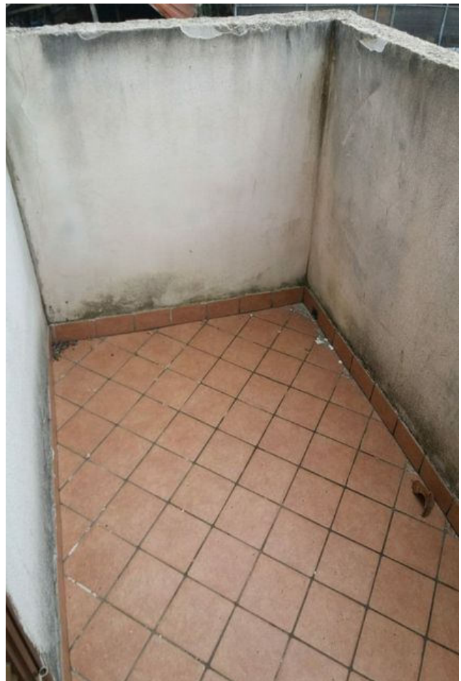
Foto 36 – Vista del balcone del piano primo
