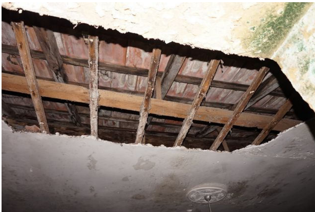
Foto 19 – Vista interna del locale 1 e della copertura del manufatto con il controsoffitto in gesso
