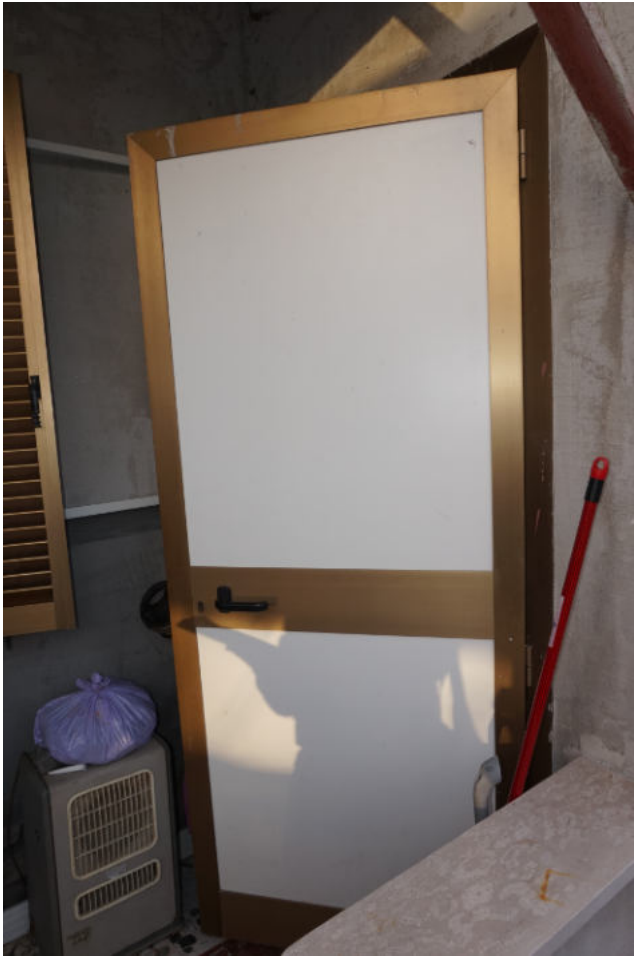
Foto 37 – Il portoncino del ripostiglio posto a lato del piccolo portico
