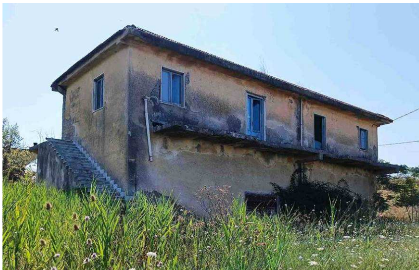
Vista esterna - lato sud/est
