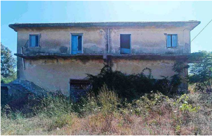
Vista esterna - lato est
