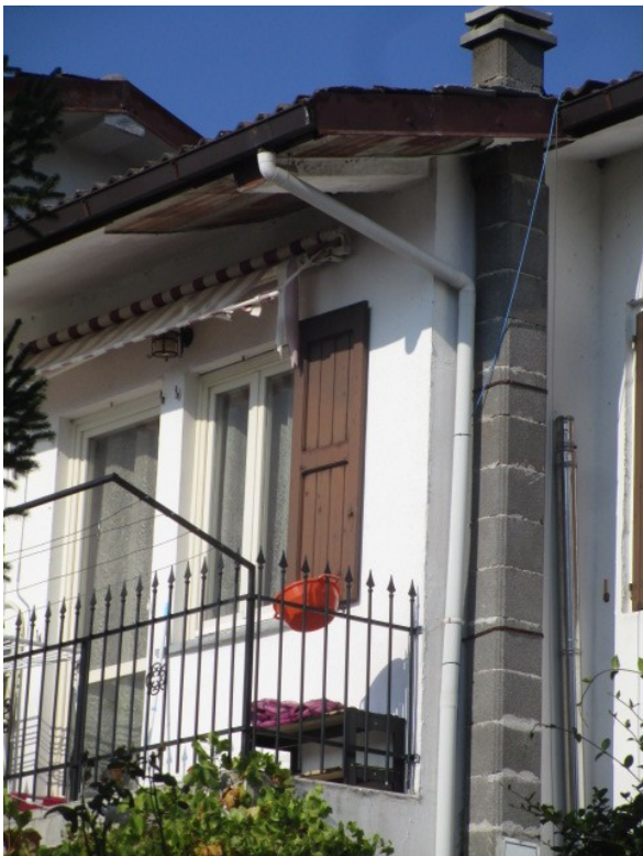
Figura 25: Balcone del soggiorno, al primo piano, affiancate dalle finestre della cucina e bagno.
