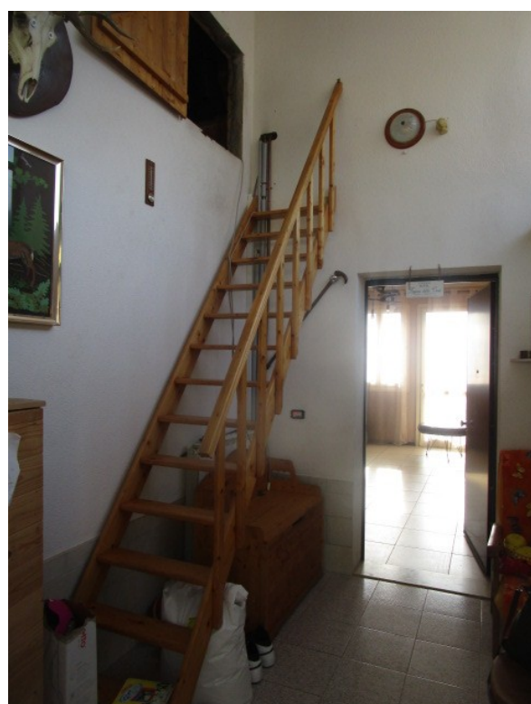
Figura 28: Scala in legno, non prevista dalla licenza di costruzione, in collegamento al portico, con il sottotetto dell'alloggio.
