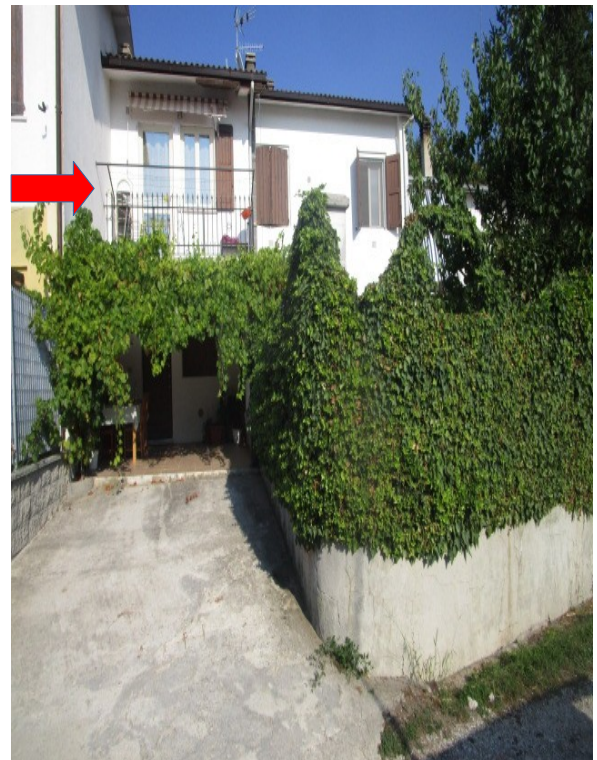
Figura 24: Prospetto dell'edificio, retrostante all'ingresso dell'appartamento (piano 1°).
