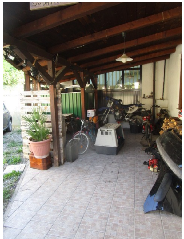
Figura 4: Pavimentazione su sedime comune e costruzione in legno, a ridosso dell'abitazione in confine, di altro dominio.
