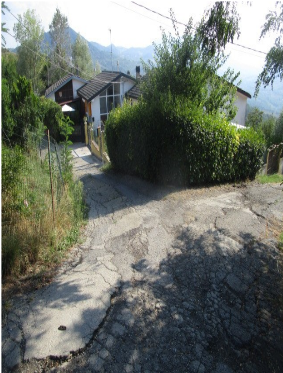
Figura 1: Ingresso alla lottizzazione, con la viabilità in dissesto, presso località Carviano, nel comune di Grizzana Morandi (BO).
