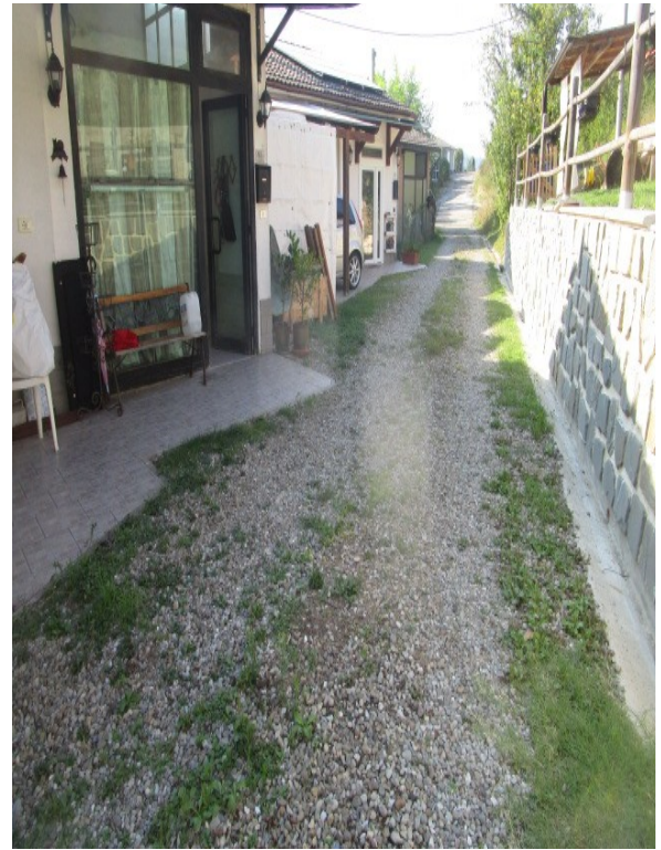
Figura 2: Portico d'accesso all'abitazione, in via Carviano 83/G, con veranda e pensina irregolari, per l'assenza di titoli edilizi.
