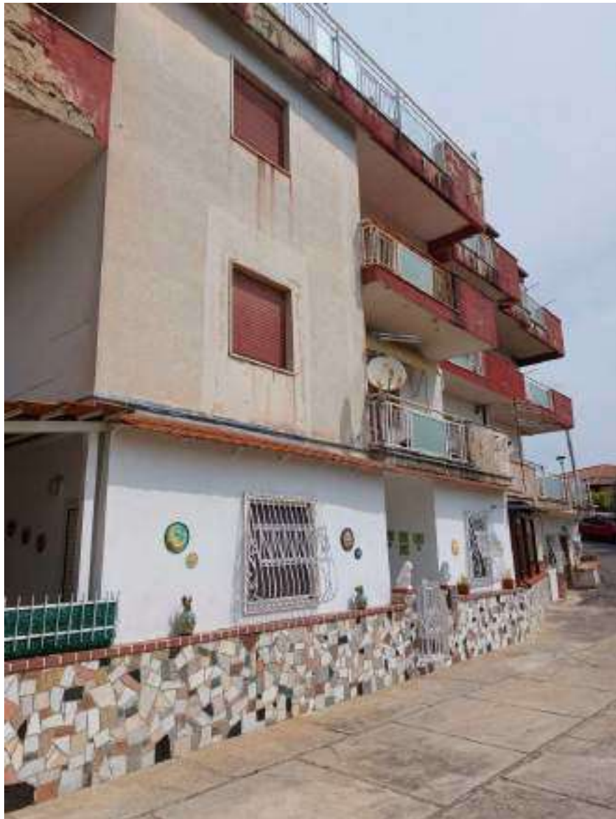
Foto N.1: Prospetto fabbricato Est con spazio esterno condominiale.
