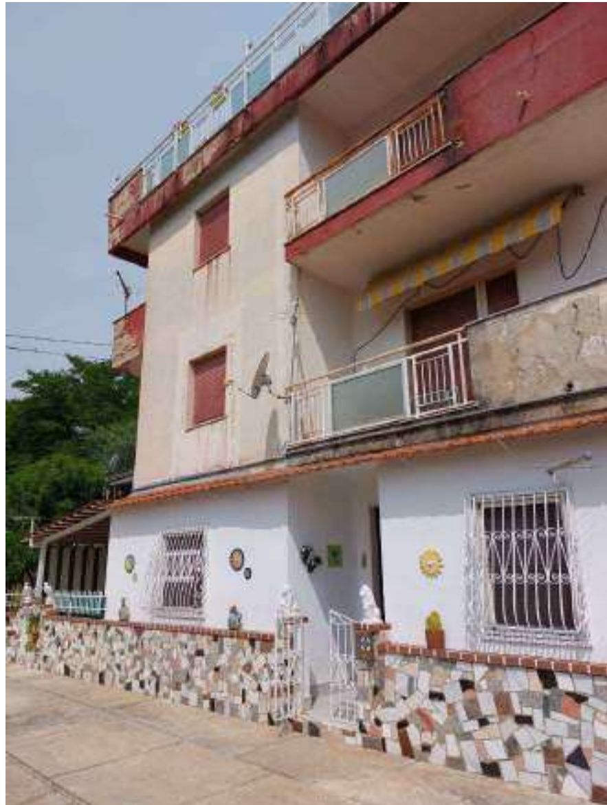
Foto N.2: Prospetto fabbricato Est con ingresso appartamento.
