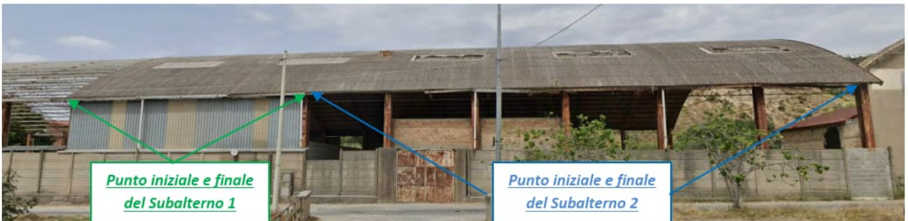
Figura 6: Vista esterna (lato strada) dei subalterni 1 e 2
