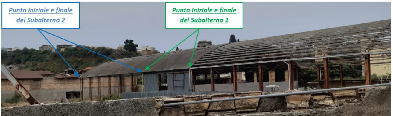
Figura 7: Vista interna (lato Particella 752) dei subalterni 1 e 2
