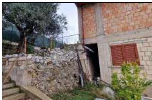
Fig. n.21 – Stato attuale muro
