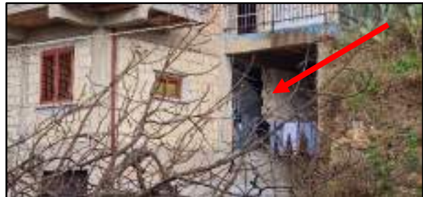
Fig. n. 5 – Accesso alla porzione immobiliare pignorata
