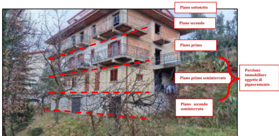
Fig. n. 3 – Vista del fabbricato in cui ricade la porzione immobiliare oggetto di pignoramento dalla parte opposta rispetto alla Via Roma (Prospetto Sud – Ovest)
