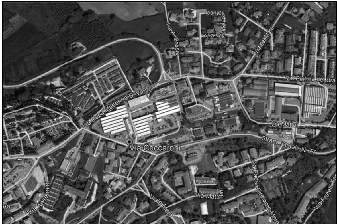
Fig. 2: Contesto in cui si inserisce l'edificio
