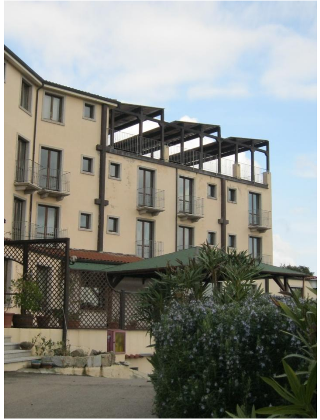
VISTA HOTEL LATO ACCESSO PRINCIPALE
