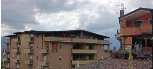
FOTO 3 – ESTERNO VISTA PROSPETTO PRINCIPALE
