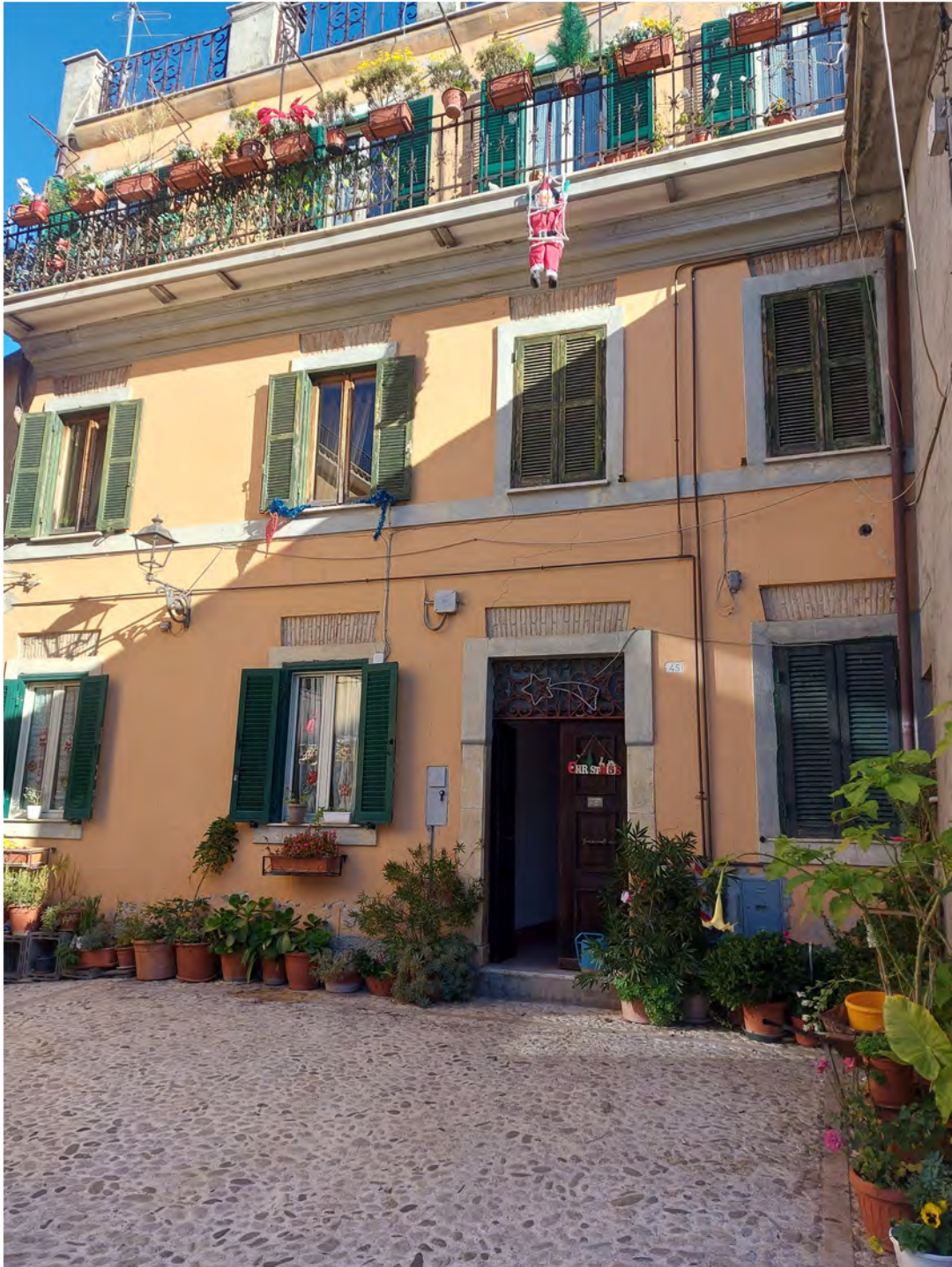
FOTO N. 1- Vista dell'immobile sito nel centro storico di Montopoli di Sabina, al primo piano del quale si trova l'appartamento individuato al fg. 10 del detto comune part. 27 sub 2, composto da ingresso-disimpegno, salone con angolo cottura, tre camere da letto, due bagni.
