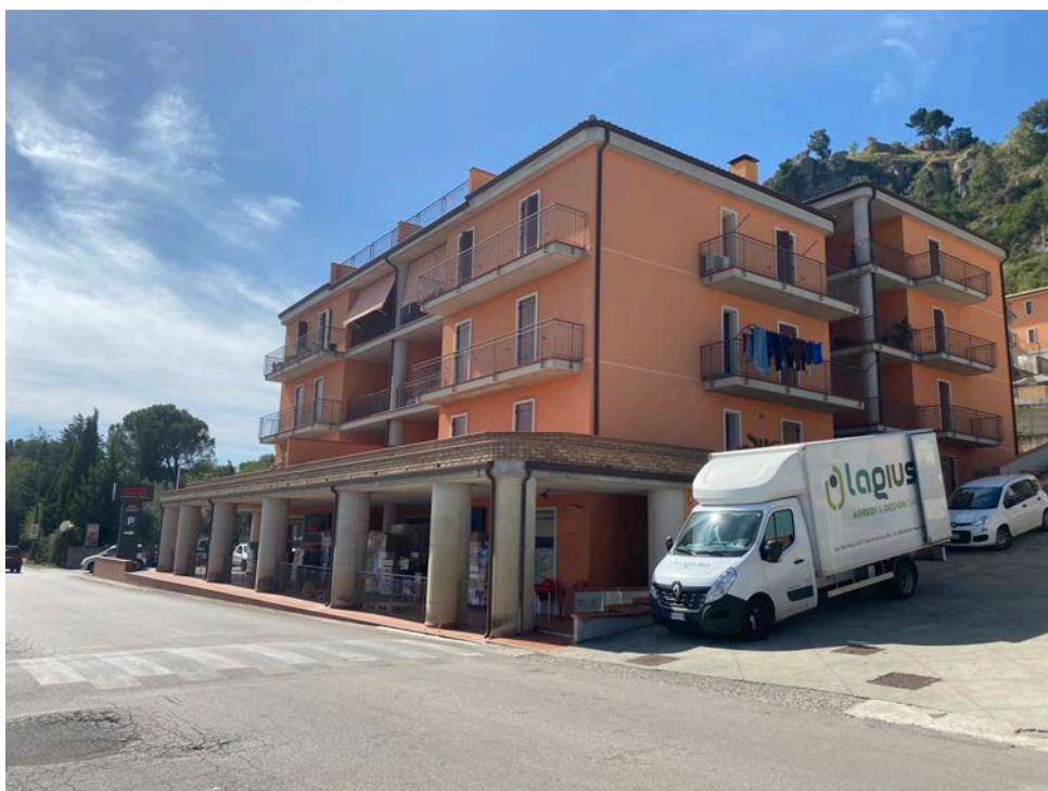
FOTO 1 - VISTA COMPLESSIVA IMMOBILE
