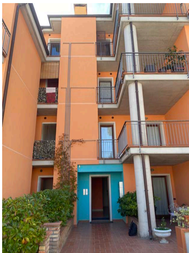
FOTO 2 - VISTA INGESSO DELLO STABILE
