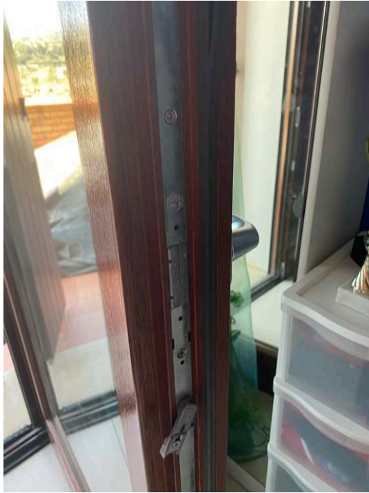
FOTO 20- PARTICOLARE DEGLI INFISSI IN LEGNO
