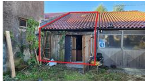
Vista esterna autorimessa
