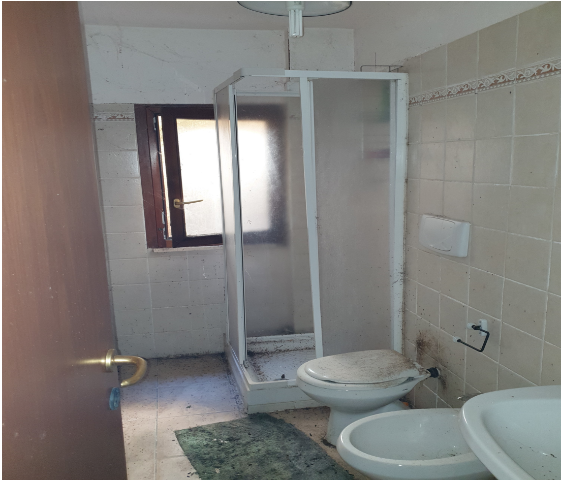
Foto nr.7 – Servizio igienico
