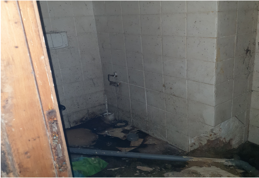
Foto nr.3 – Servizio igienico
