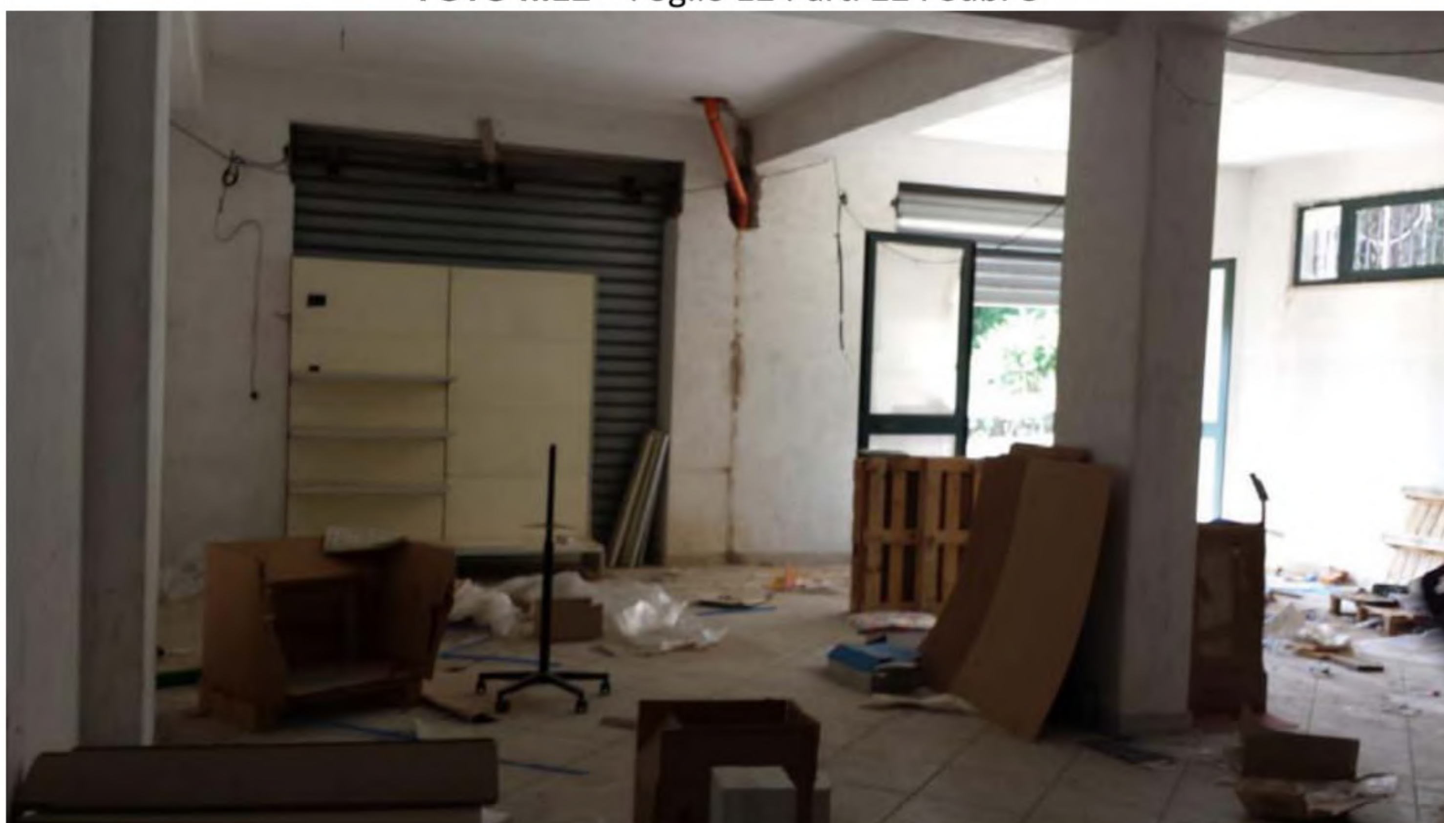
FOTO n.12 – Foglio 12 Part. 224 Sub. 8
