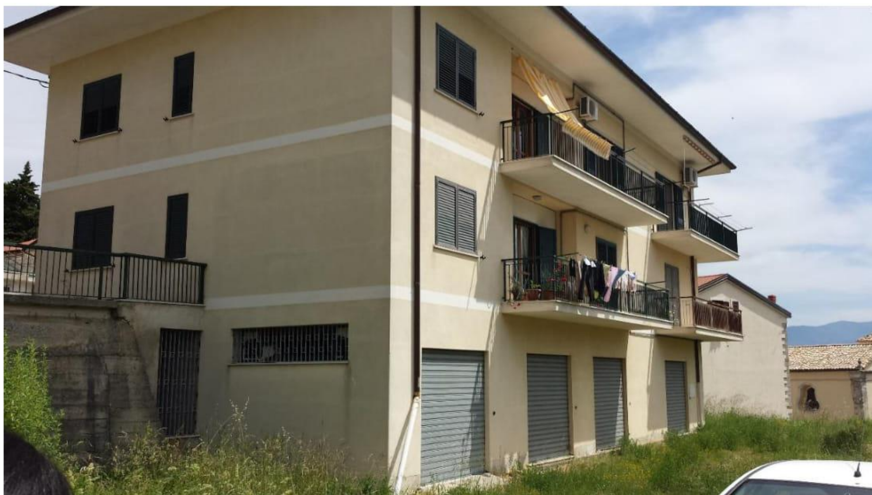
FOTO n.5 – Foglio 12 Part. 224 Sub. 6,7,8
