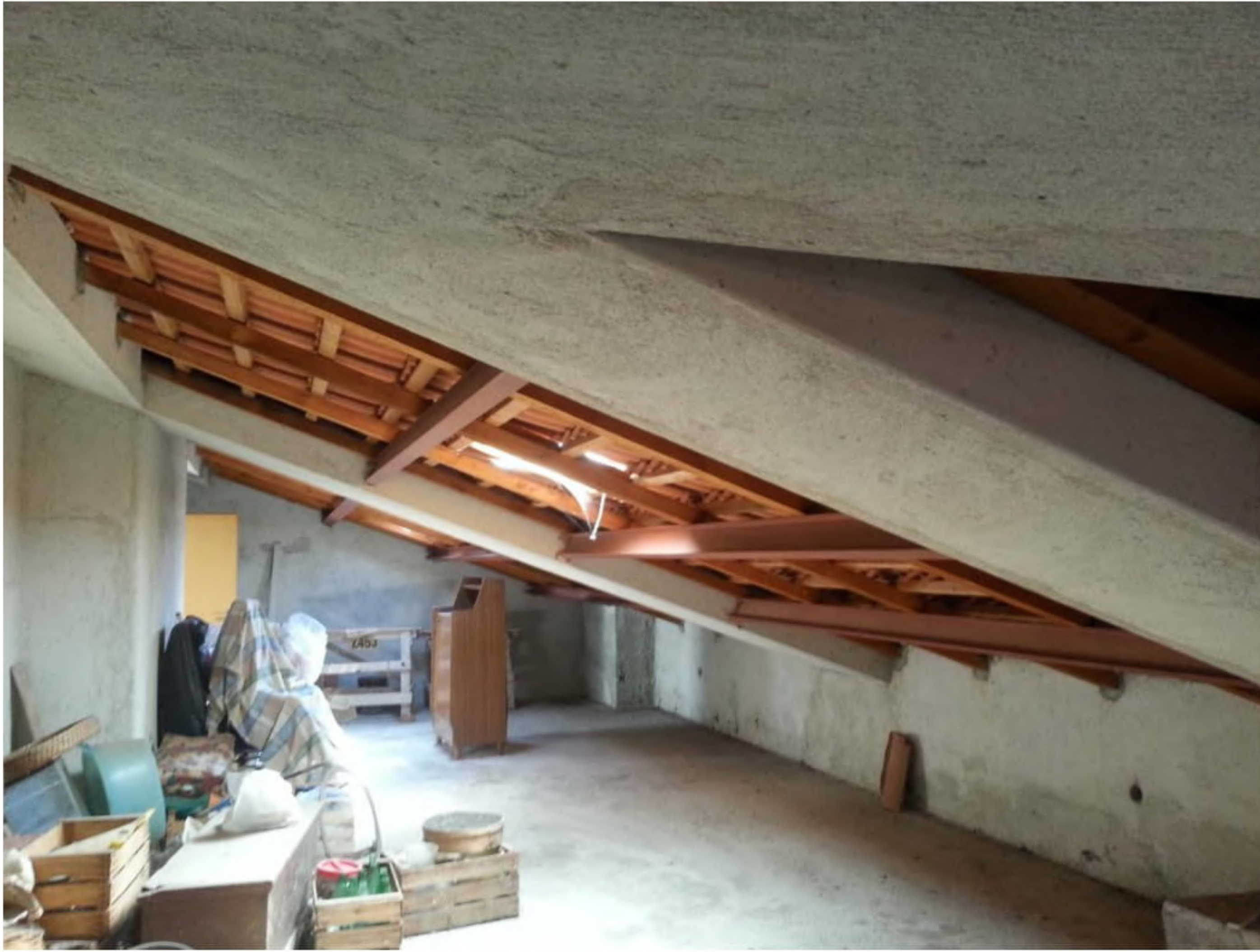
FOTO n.15– Foglio 12 Part. 224 Sub. 5
