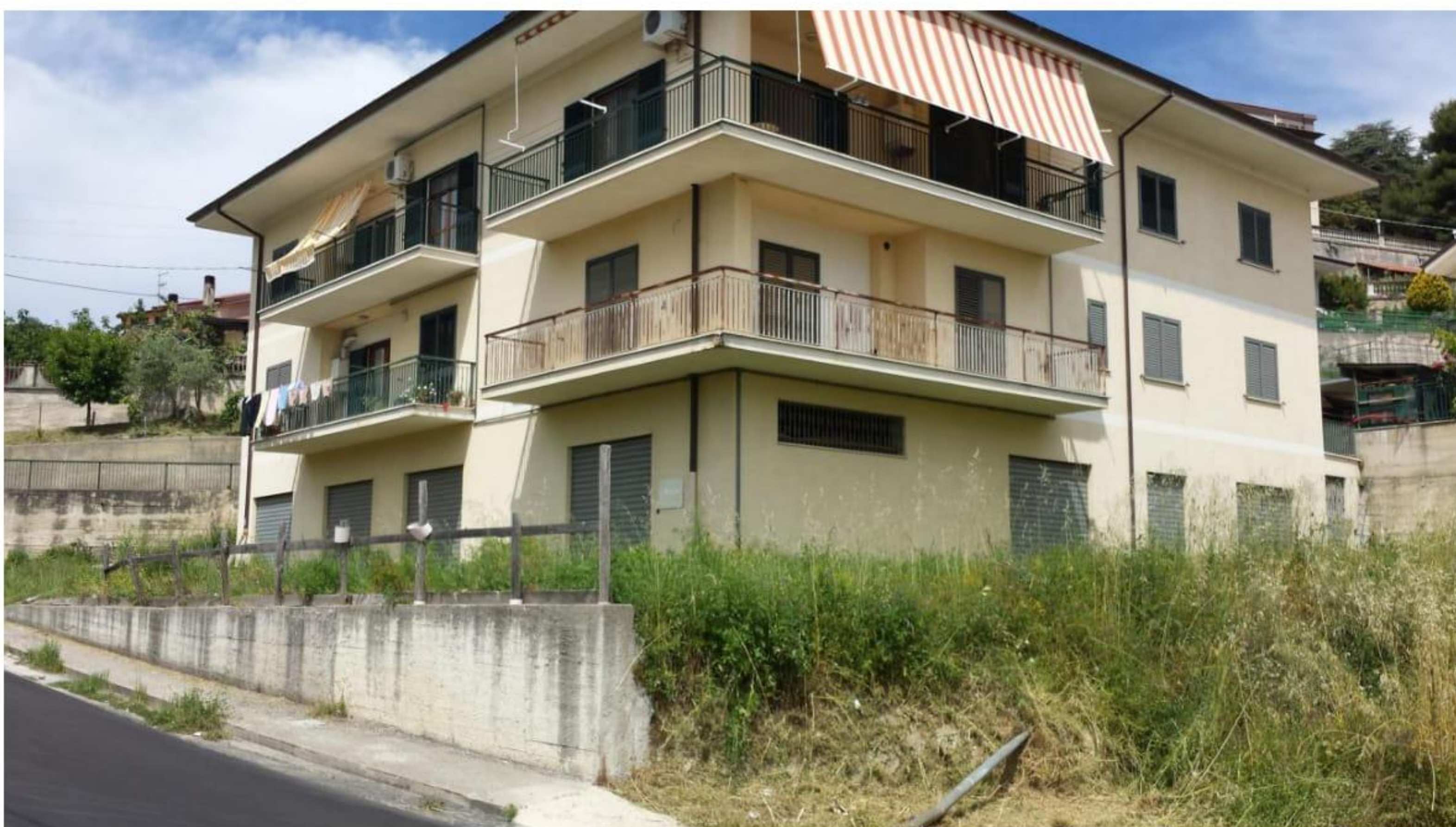
FOTO n.7 – Foglio 12 Part. 224 Sub. 6,7,8
