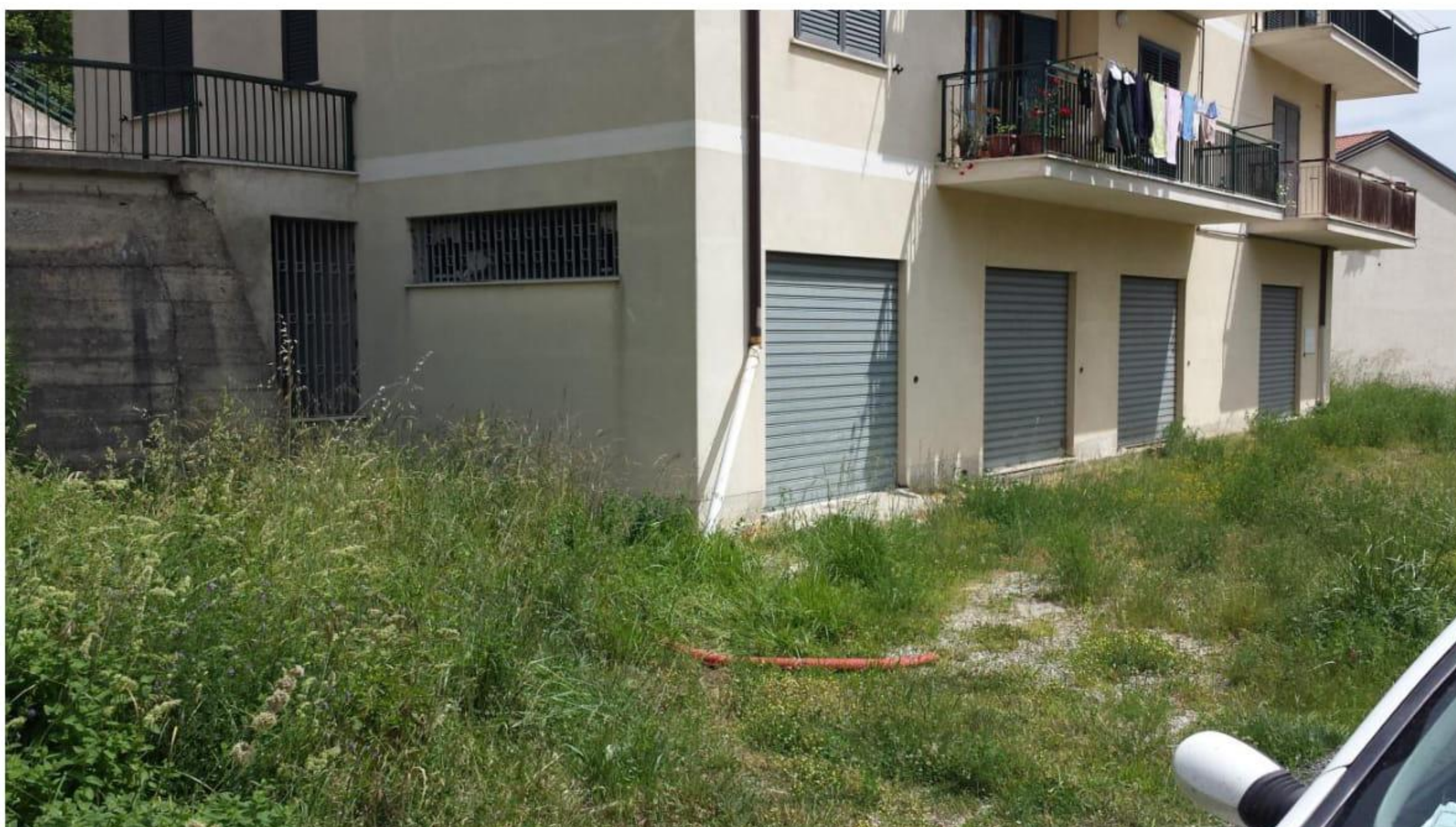
FOTO n.6 – Foglio 12 Part. 224 Sub. 6,7,8
