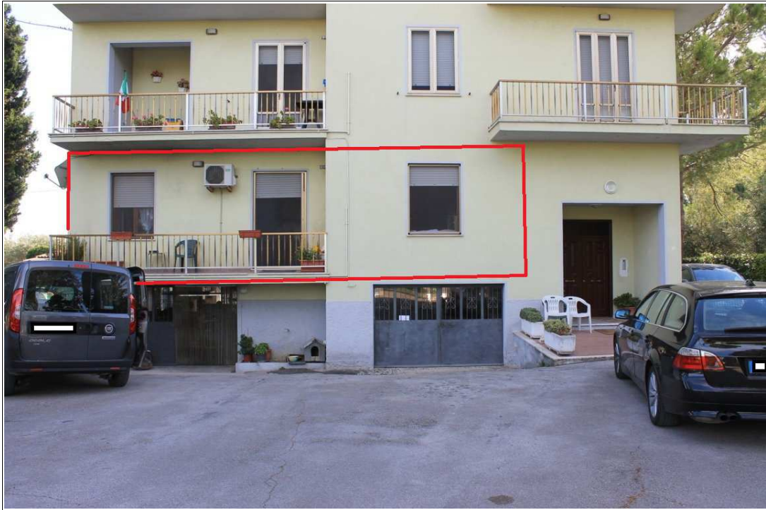
FOTO 1: Fronte est fabbricato
