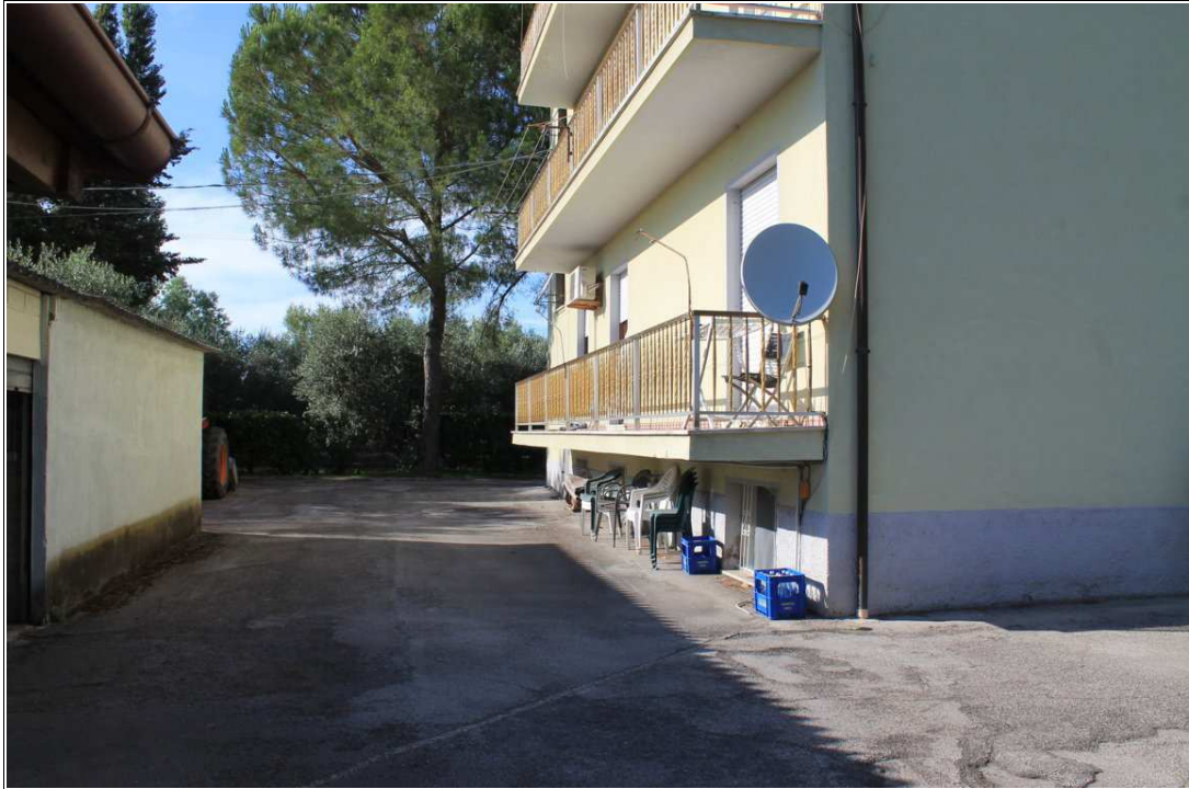
FOTO 3: Fronte ovest fabbricato
