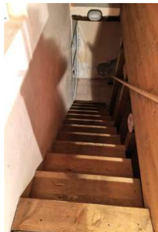
Scala al piano interrato
