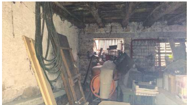
Vista legnaia piano terra
