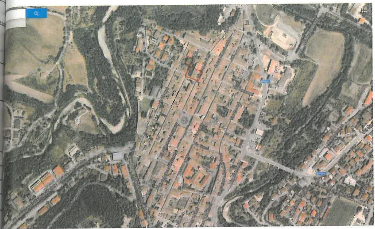
Foto 1 - Vista aereofotogrammetrica del compendio immobiliare all'interno del centro storico di Cagli (PU), con individuazione (in rosso) del Palazzo Felici-Balloni e dello scoperto in via Purgotti.
