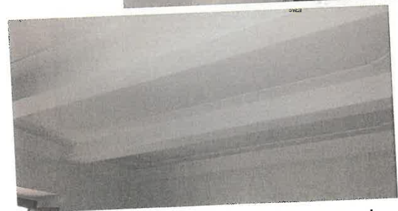
Foto 48, 49 e 50 – Vedute dei soffitti degli uffici del piano secondo.
