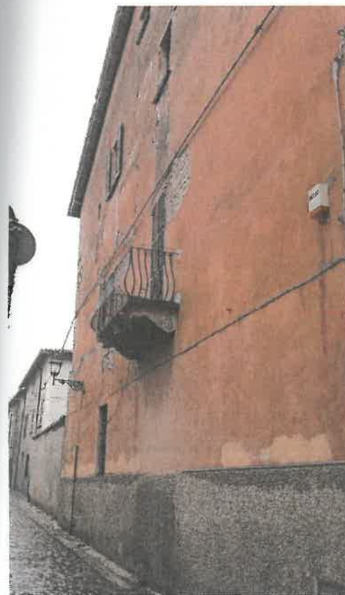
Foto 6 – Vista del fianco su via Bonclerici.
