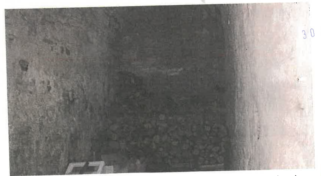
Foto 16 – Vista del vano minore (corridoio "cieco") al piano interrato adibito a legnaia.
