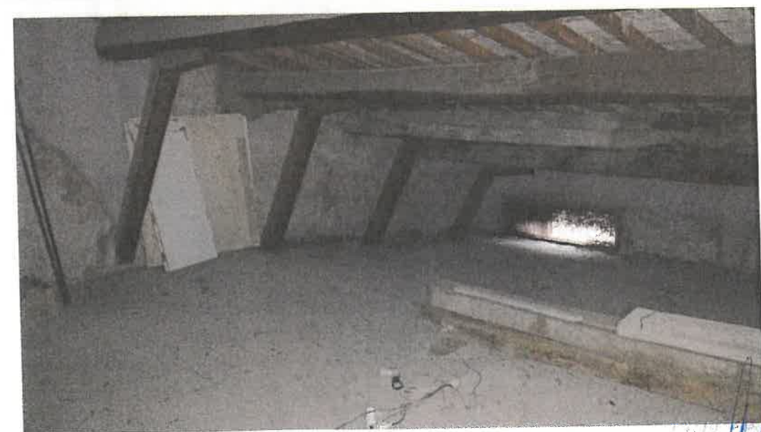
Foto 52 e 53 – N. 2 viste parziali di vani al piano sottotetto ad uso soffitta.
