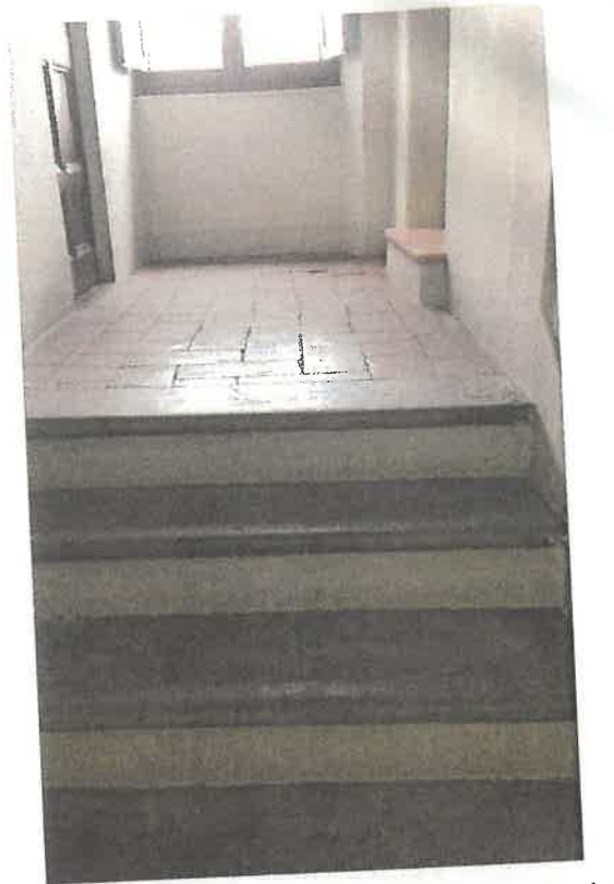
Foto 40 e 41 – Particolari della rampa del vano scala che conduce al piano secondo (pedate in pietra e pianerottoli in piastrelle di cotto).
