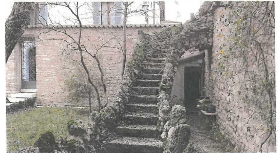
Foto 11, 12 e 13 – N. 3 viste dello scoperto sul retro al piano terra con particolare della scala esterna.
