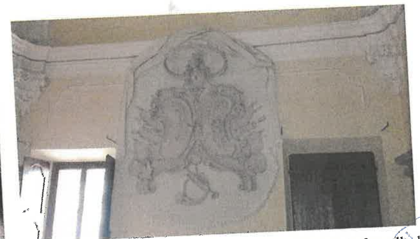
Foto 38 e 39 - Alcuni particolari di pregio interni al salone (portale, pavimento bicolore in formelle di cotto, cornici, uno dei due grandi stemmi lapidei, ecc...) che arricchiscono l'immobile.
