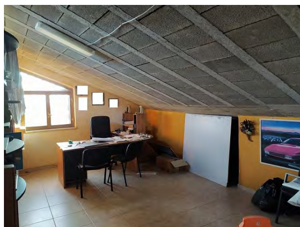
Vano piano sottotetto sub. 1
