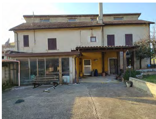
Vista della facciata posteriore del fabbricato
