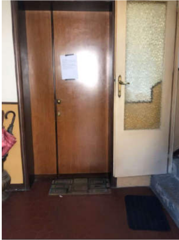
Ingresso con androne comune
