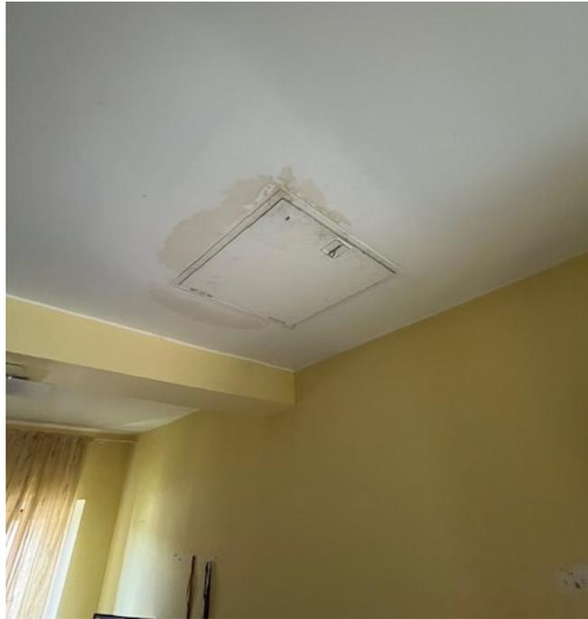
Piano primo: botola a soffitto nella camera, con segni di infiltrazioni d'acqua
