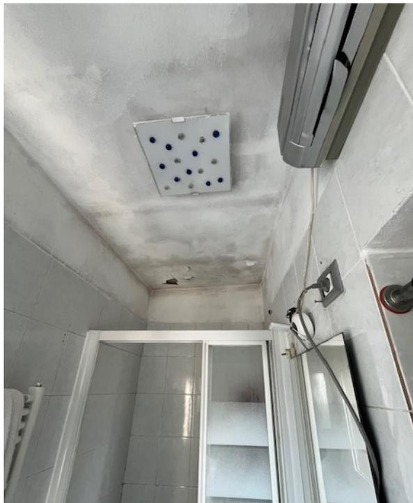
Piano primo: bagno con evidenti macchie di infiltrazioni d'acqua a soffitto
