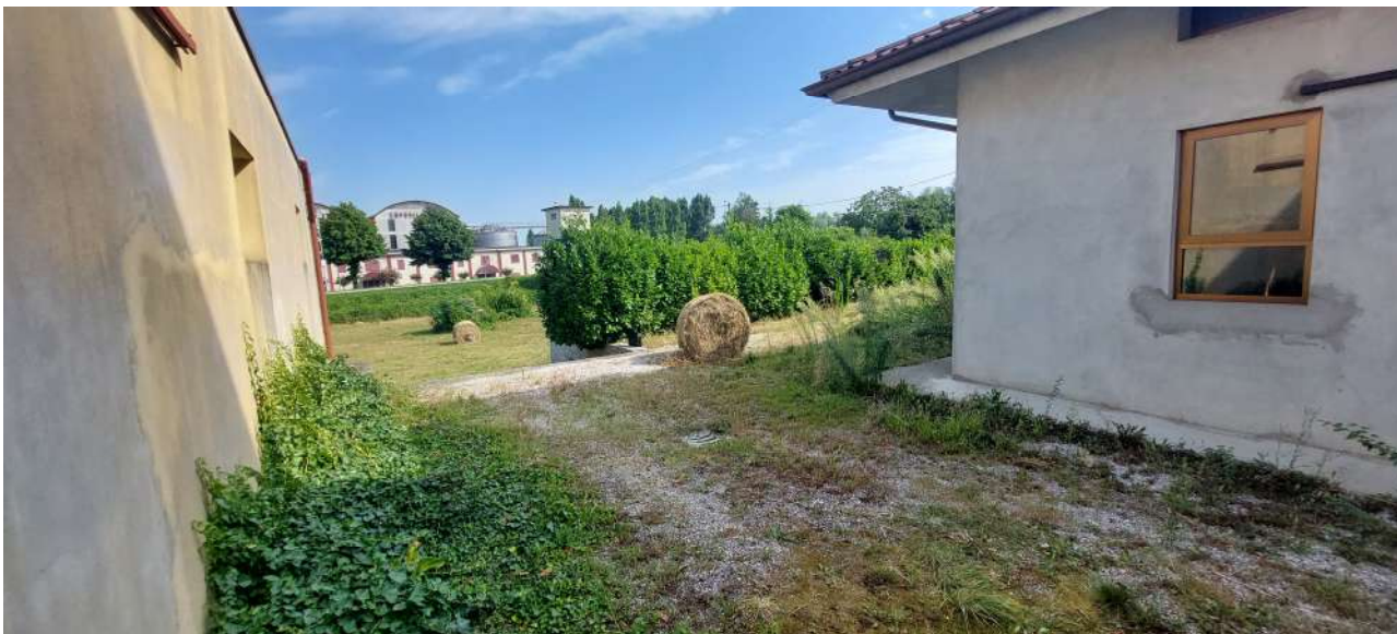
Scoperto comune di accesso al terreno edificabile (Sub. 14)
