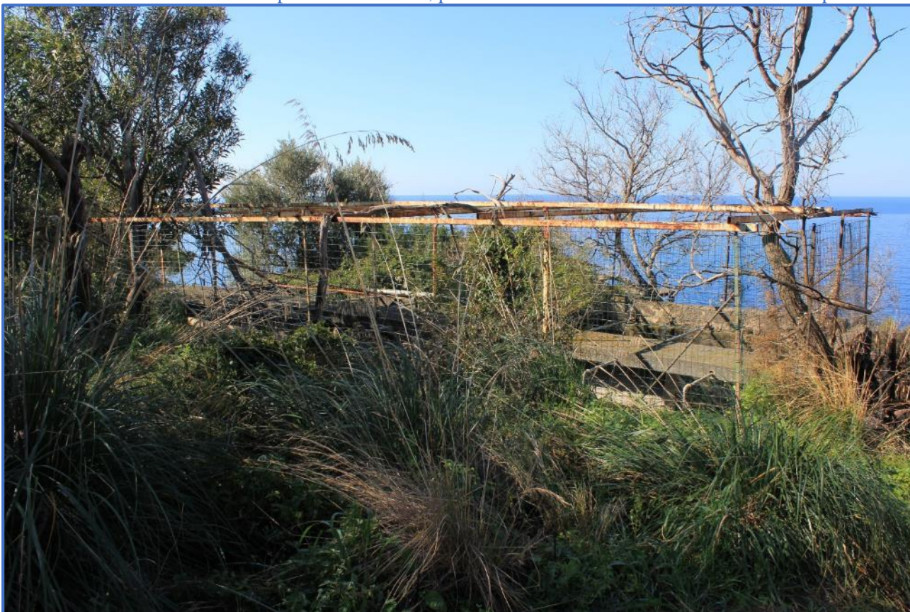
3.9 – Particelle nn. 675-673 – Depuratore dismesso, posto a confine verso i fondi serventi di cui sopra
