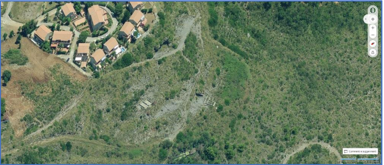
1.13, 1.14 - Bing Maps 3D – P.Ile n. 671, da 508 a 515 – Presenza di fondazioni in CLS armato e un depuratore
