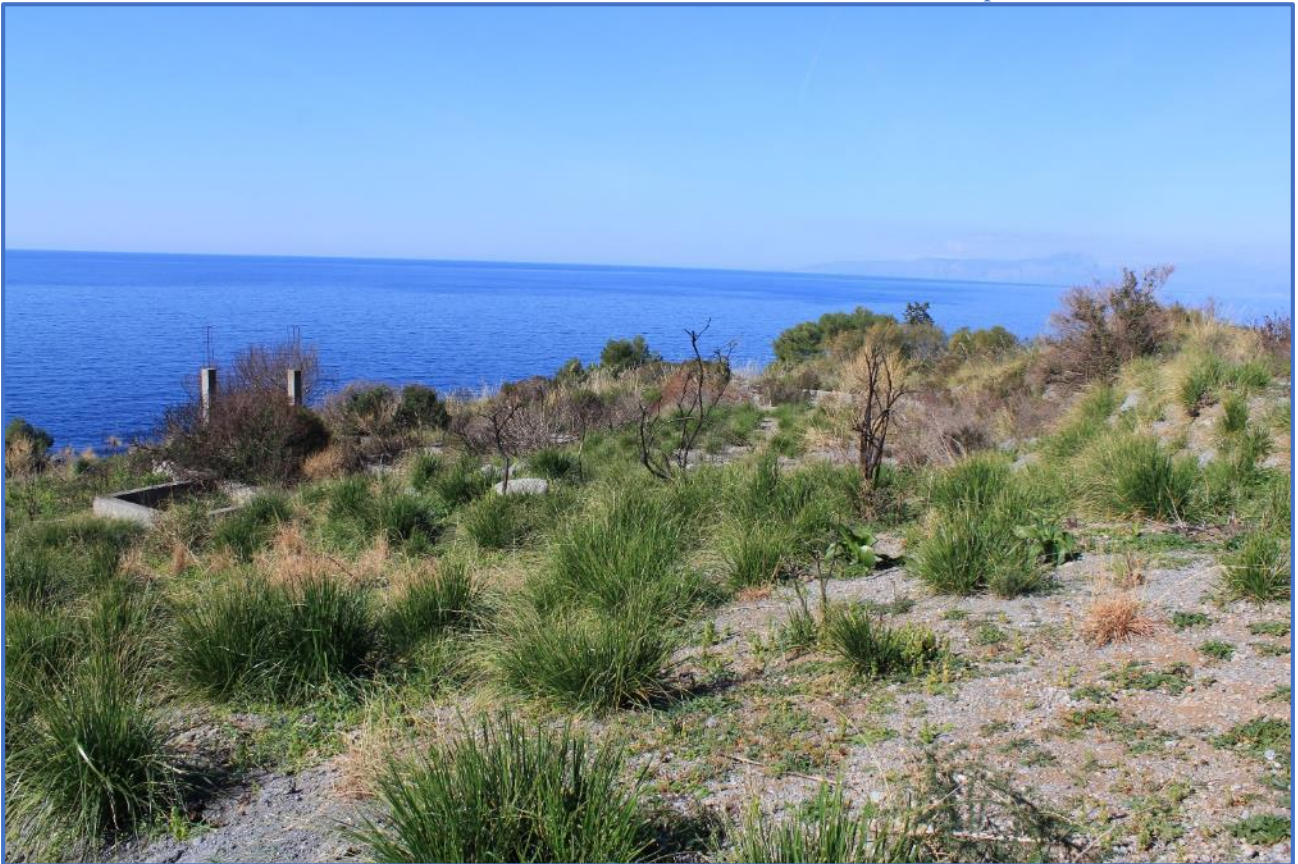
3.18 – Particelle nn. 671-508-509-510-511-512-513-514-515- Visibili fondazioni e pilastri armati
