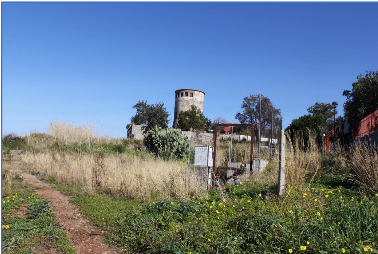
2.15 – 20/02/2023 – Particelle nn.505-506 – Visibile la stradina sterrata ed un locale tecnico di servizio
