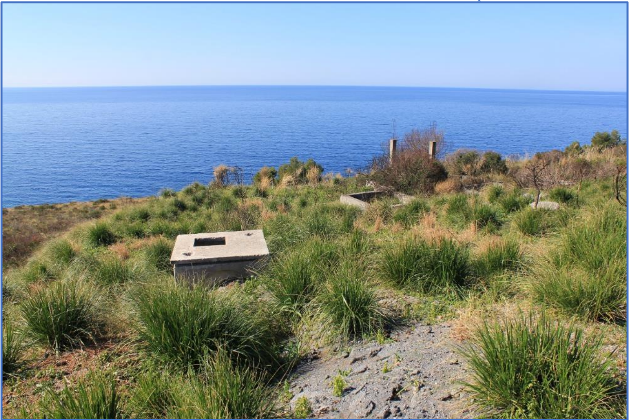
3.19 – Particelle nn. 671-508-509-510-511-512-513-514-515- Visibili fondazioni e pozzetti
