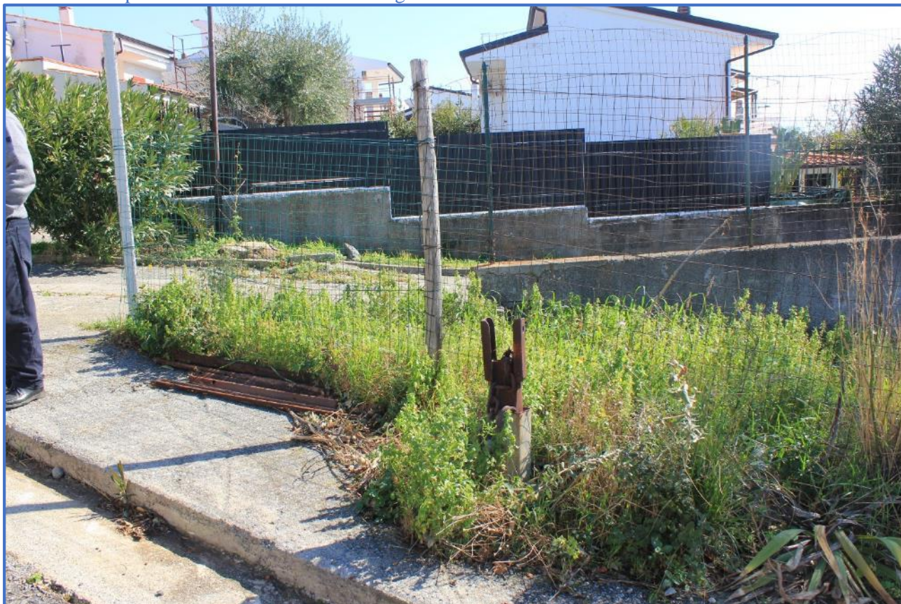
2.11 – Vertice particella n. 506: Visibile il collegamento della vecchia catena metallica rimossa.
