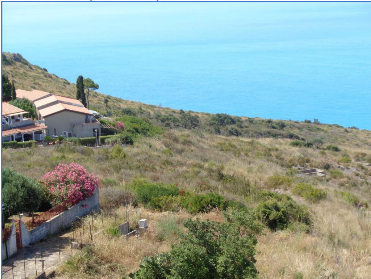
3.22 – 05/07/2024 - Vista panormica verso le particelle nn. 671, da 508 a 515- Visibili le fondazioni
