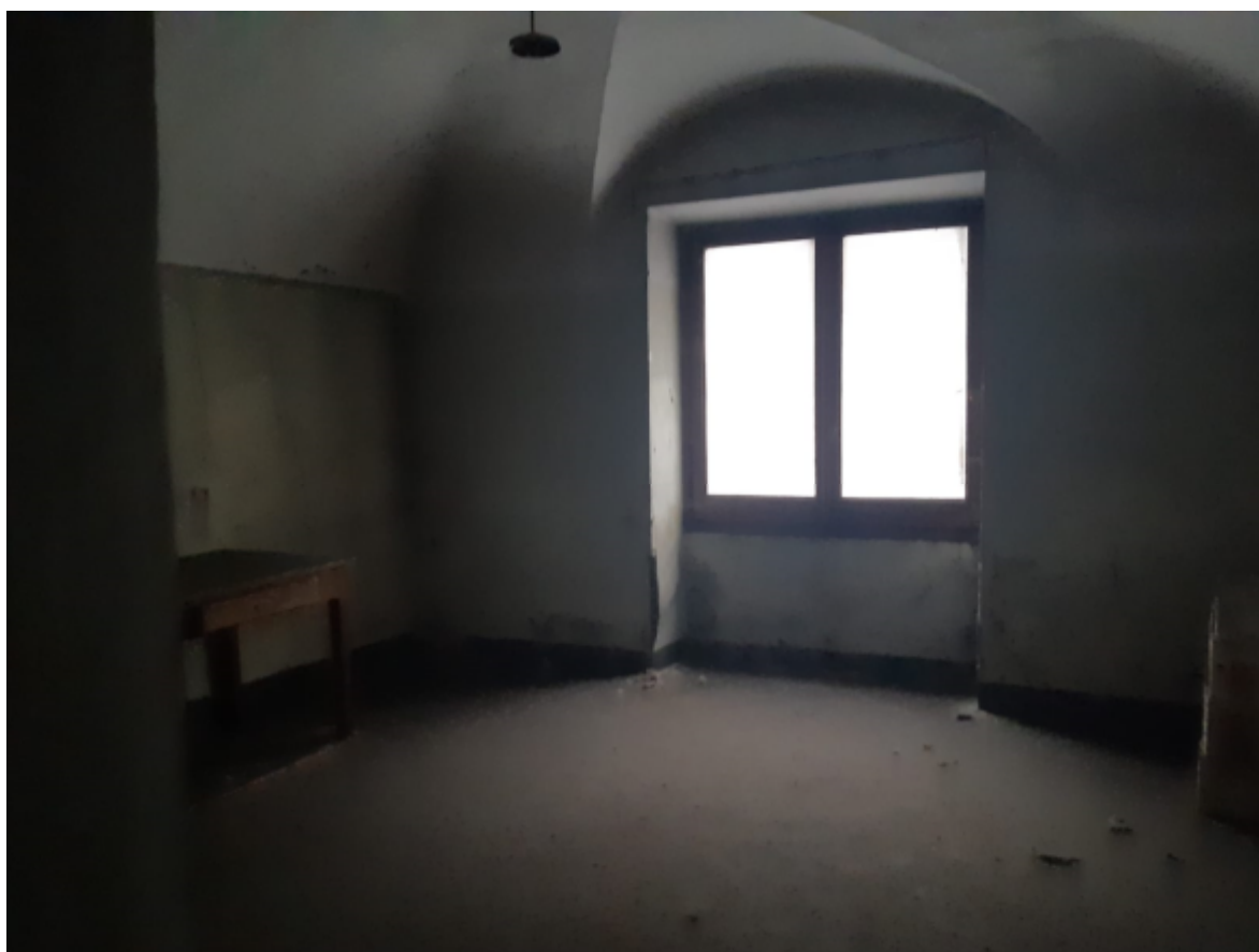
Vista interna locali in piano terra
