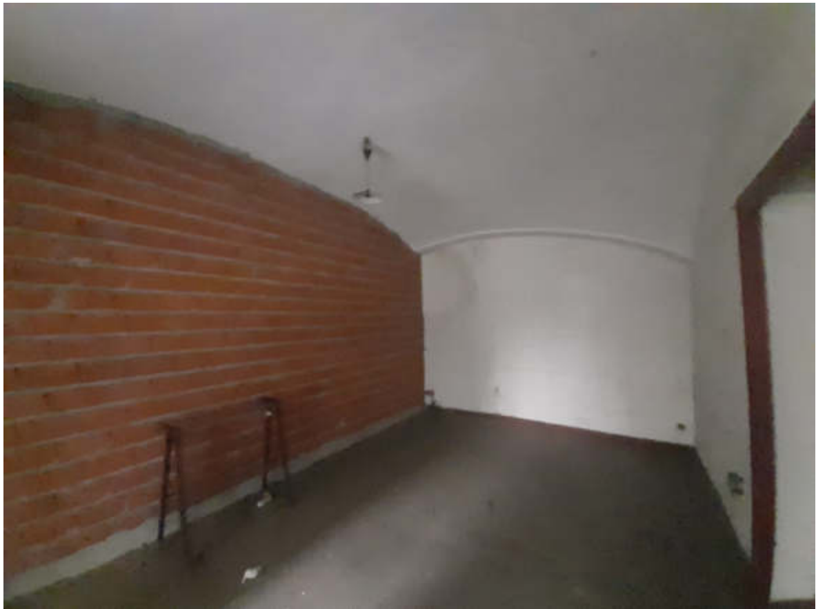
Vista interna locali in piano terra
