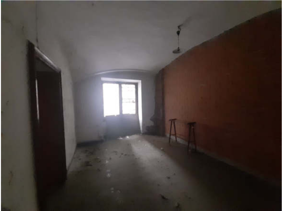
Vista interna locali in piano terra
