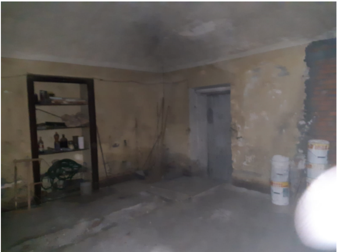
Vista interna locali in piano terra
