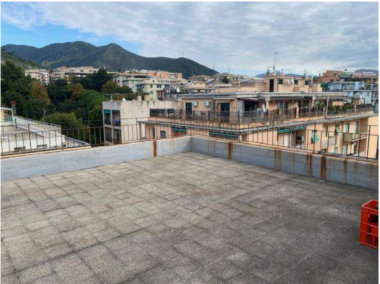
Foto 42 – Vista del lastrico solare del condominio pertinenziale all'appartamento int. 33 - (8° piano)
