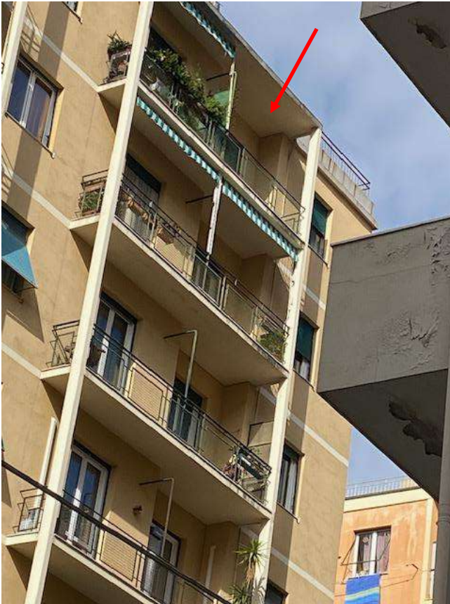
Foto 11 - Vista del balcone dell'appartamento interno int. 33 - (7° piano) che affaccia su Via Molfino
