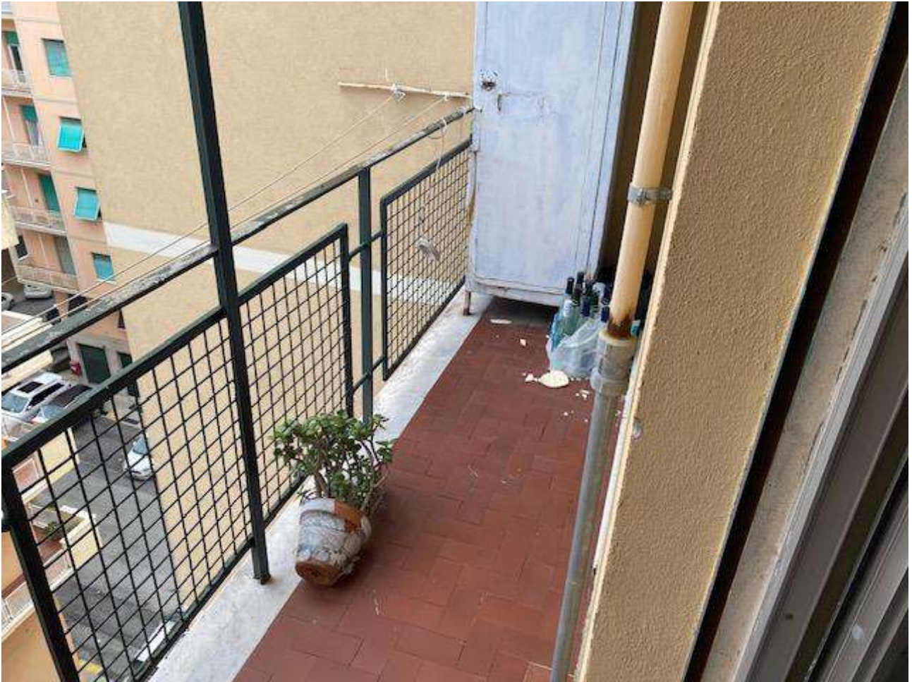
Foto 23 – Vista del balcone della Cucina e del Soggiorno
