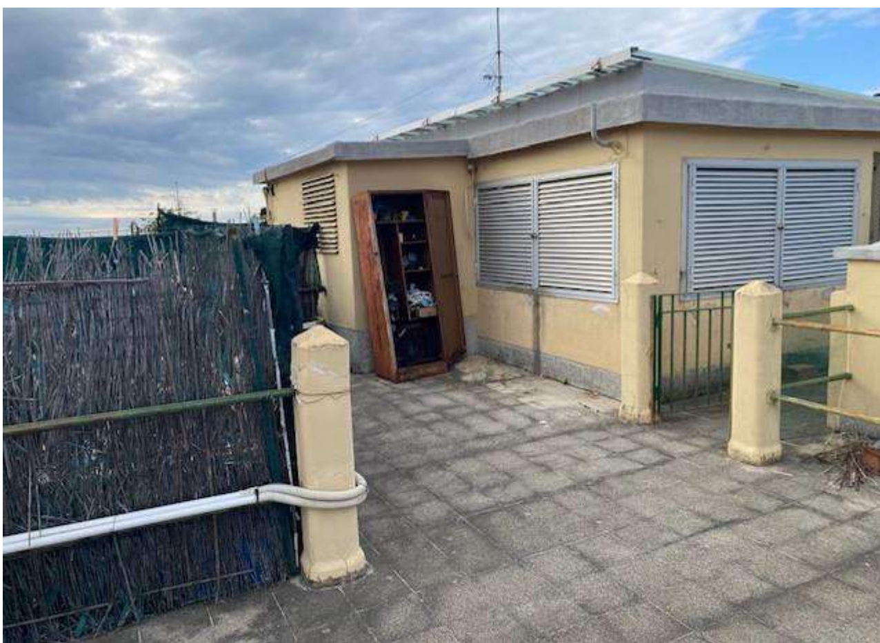
Foto 43 e 44 – Vista del lastrico solare del condominio pertinenziale all'appartamento int. 33 - (8° piano)
