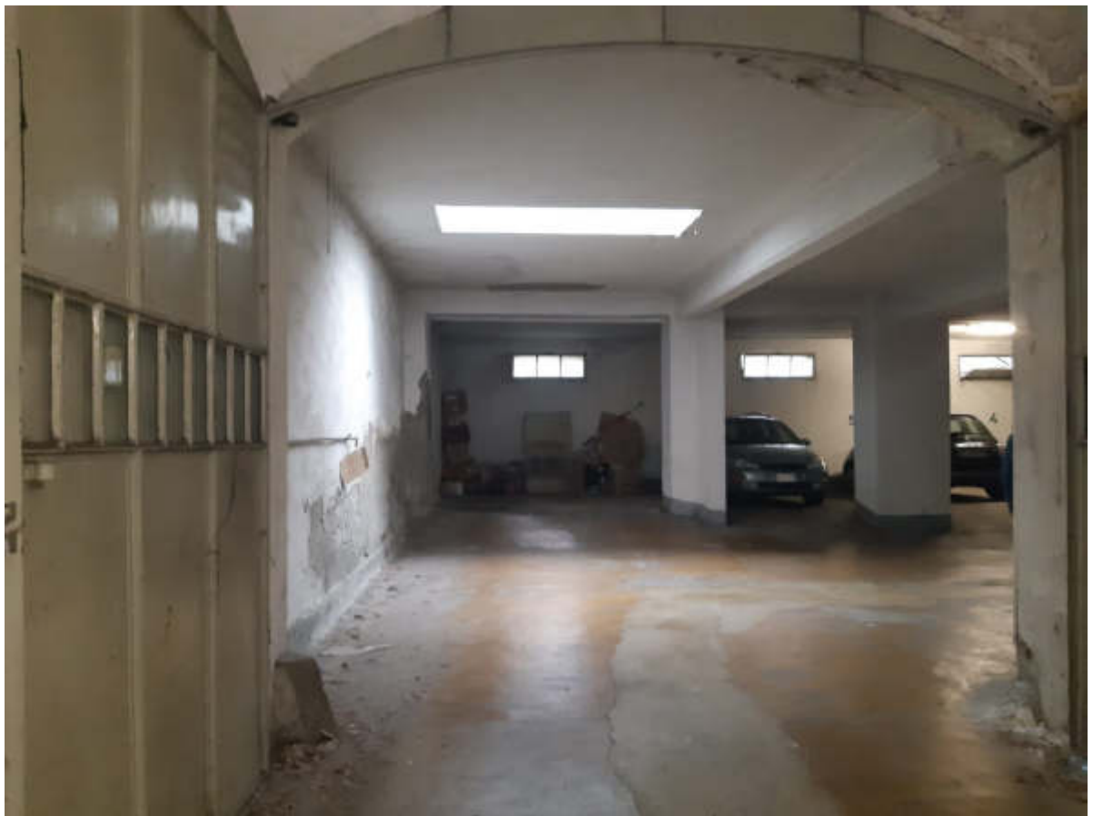
Vista interna del locale magazzino
