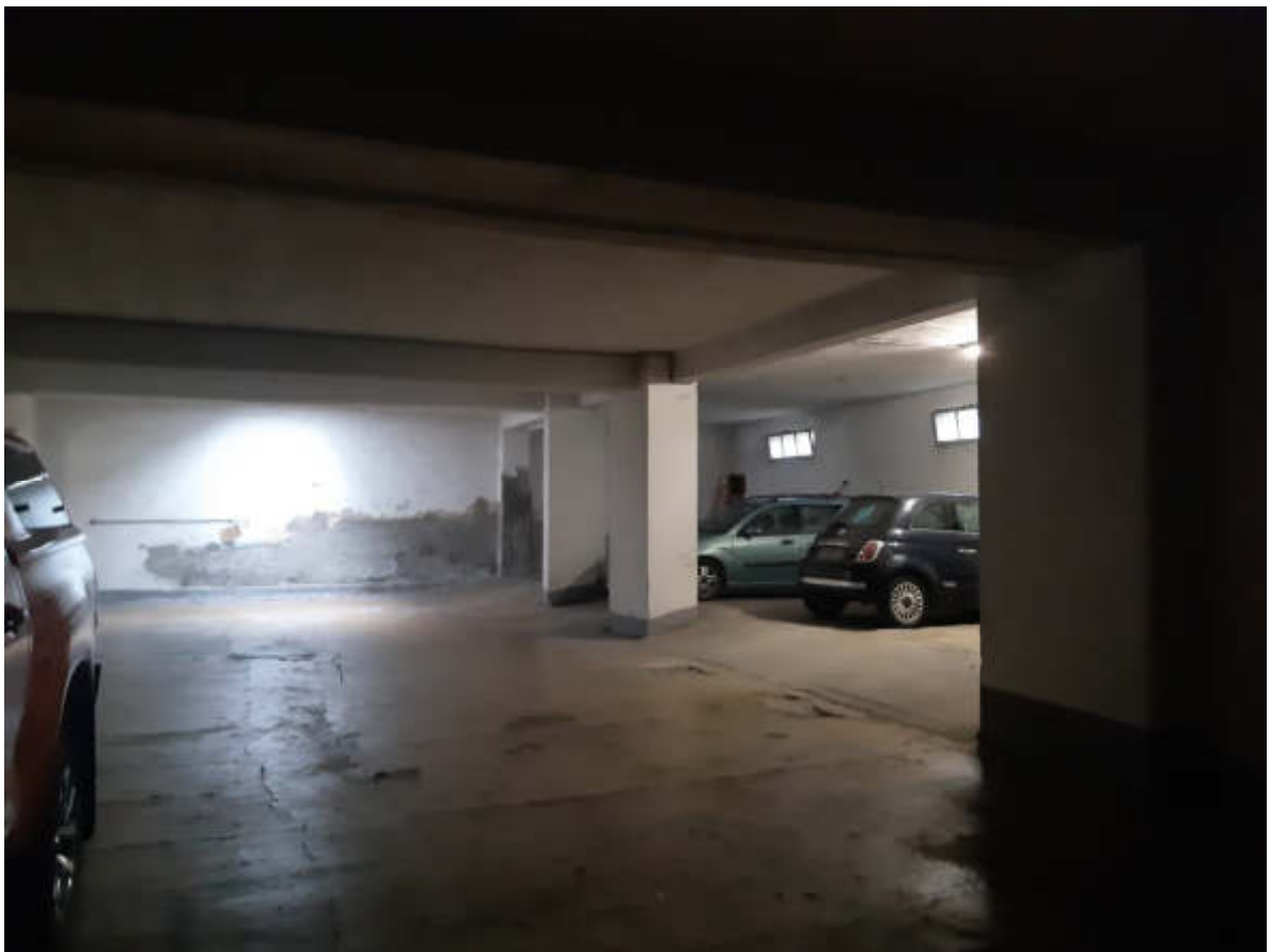
Vista interna del locale magazzino
