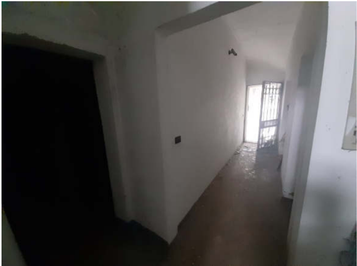
Vista dal sedime stradale pubblico della Via Mazzini del portoncino pedonale ed androne vano scala in piano terra facente parte della consistenza di altra U.I.U., dal quale viene praticato l'accesso al piano cantina
