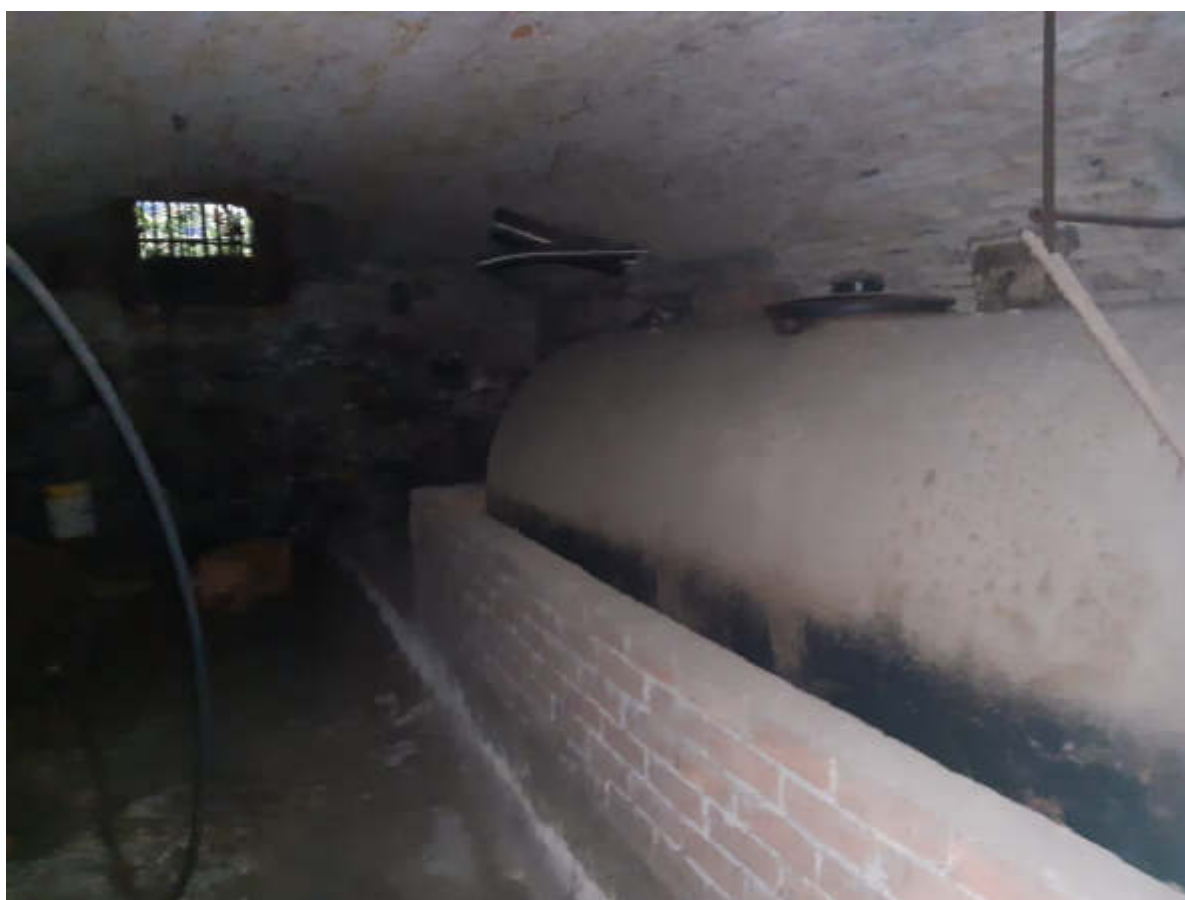
Vista in piano interrato dei locali cantina
