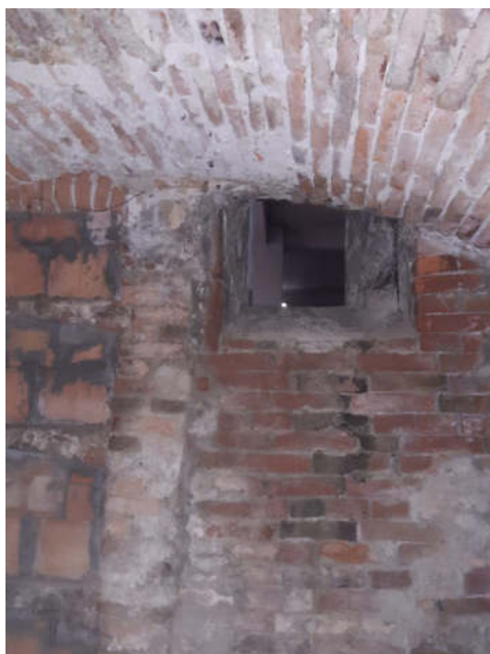
Vista in piano interrato dei locali cantina
