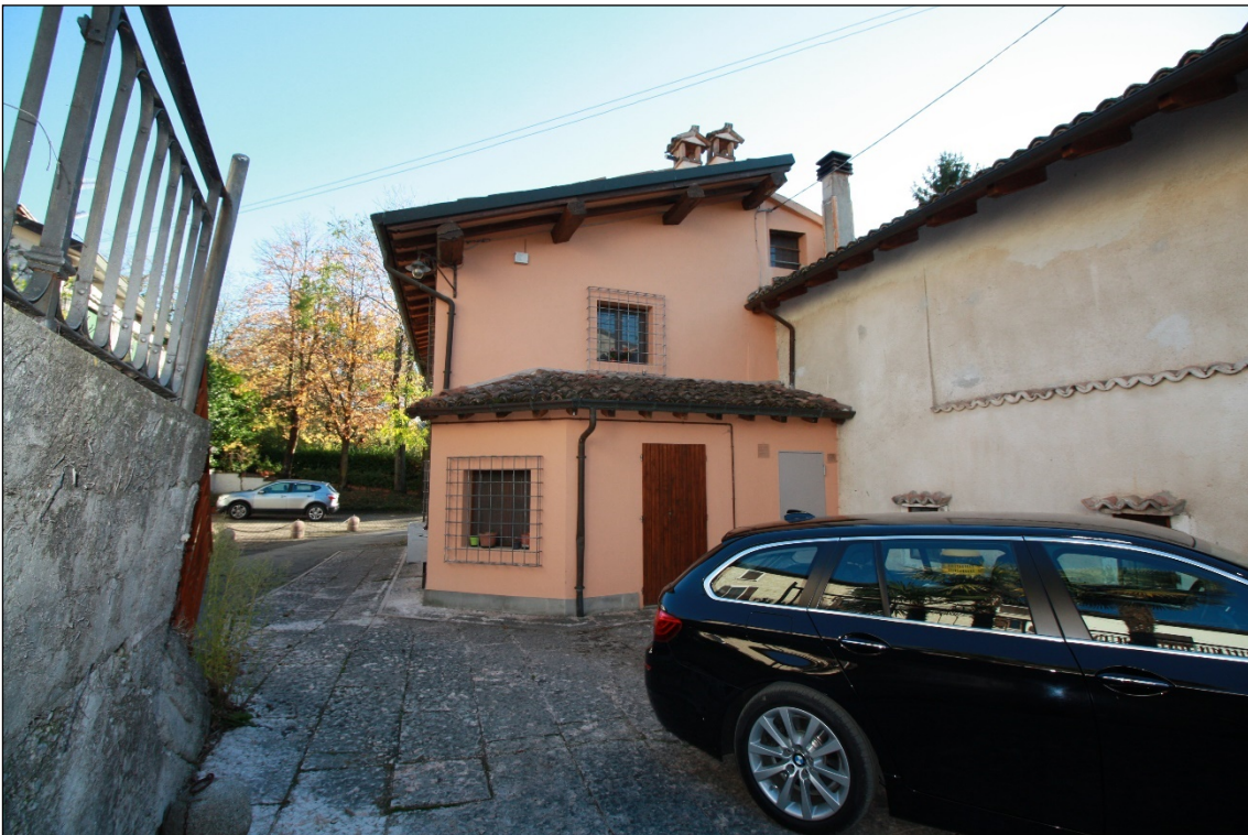
Foto n° 2: Vista dell'intero lotto
