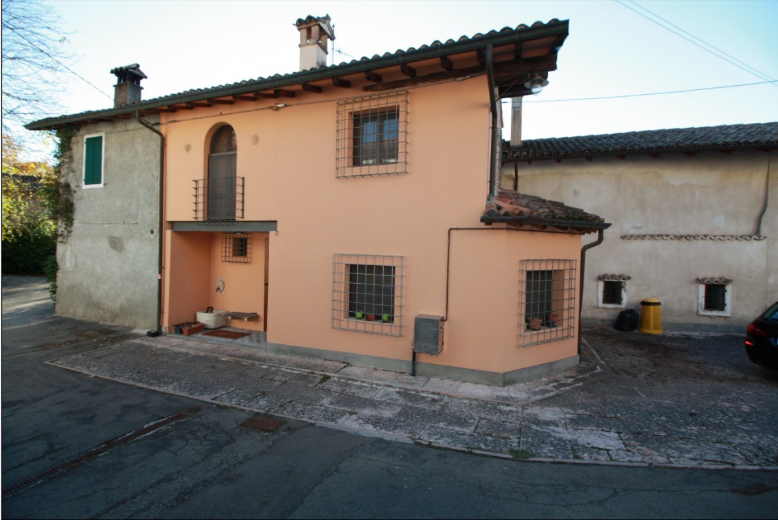
Foto n° 1: Prospetto di Est
