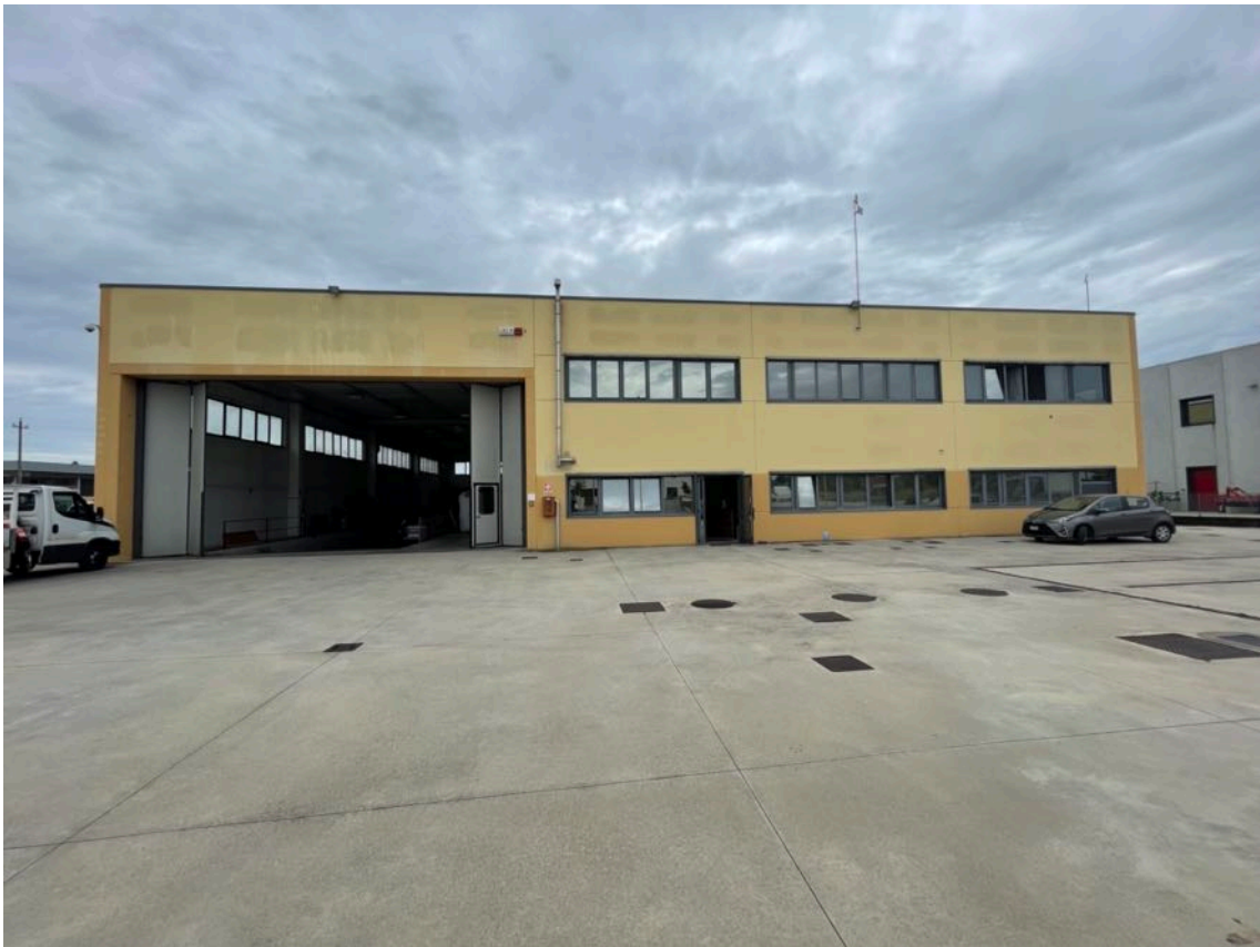
4 - Vista lato ovest
