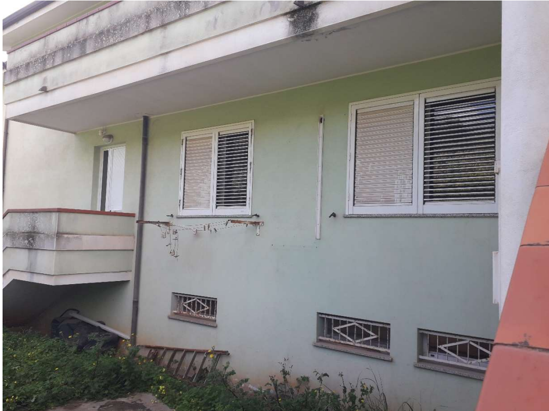
Esterno fabbricato cortile via Sarrabus
