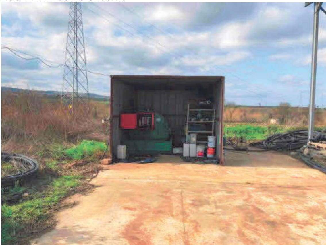
LOCALE DEPOSITO GASOLIO
