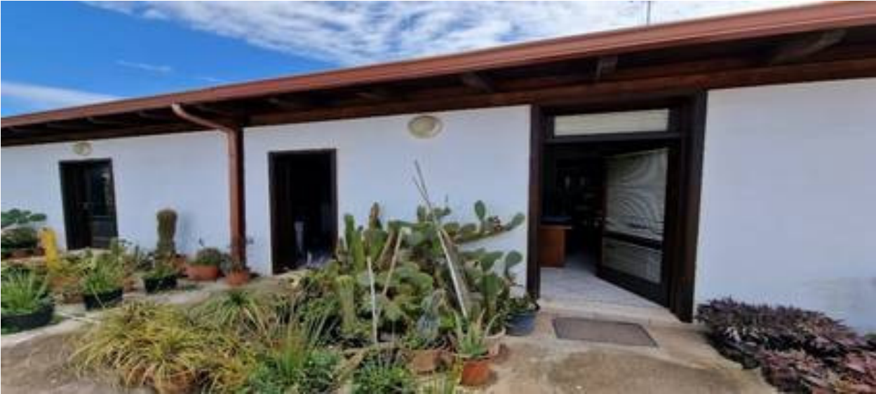
Servizi – Ufficio-Magazzino e - Wc
