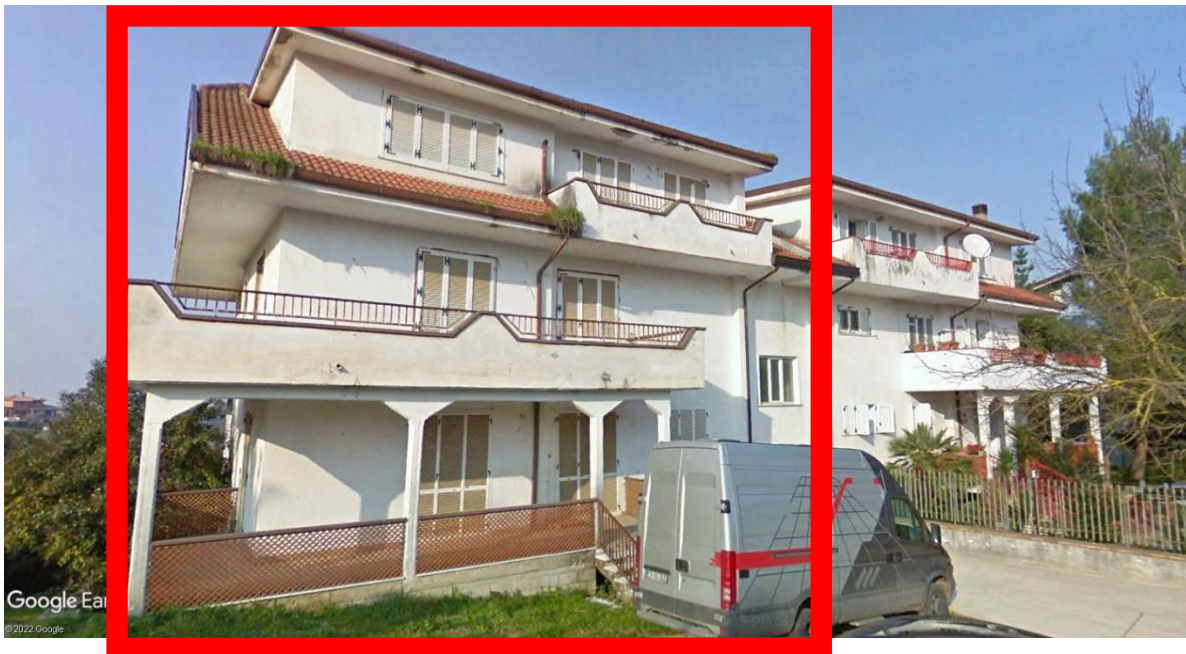
Individuazione, in rosso, della parte di fabbricato oggetto di procedura
