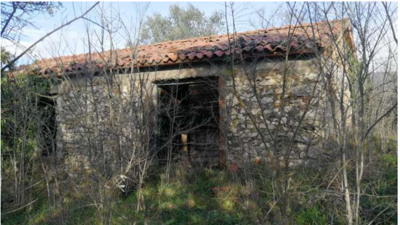
FOTO 02 – FABBRICATO RURALE (diruto) Lato Sud
