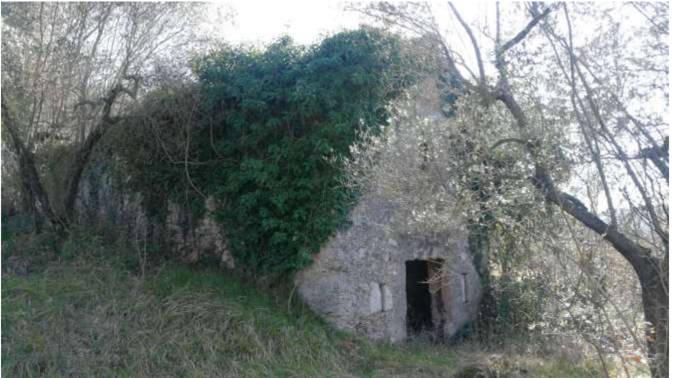
FOTO 03 – FABBRICATO RURALE (diruto) scorcio Nord-Ovest
