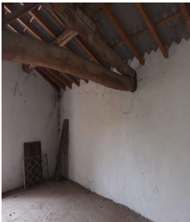
Locale al piano primo con particolare copertura
