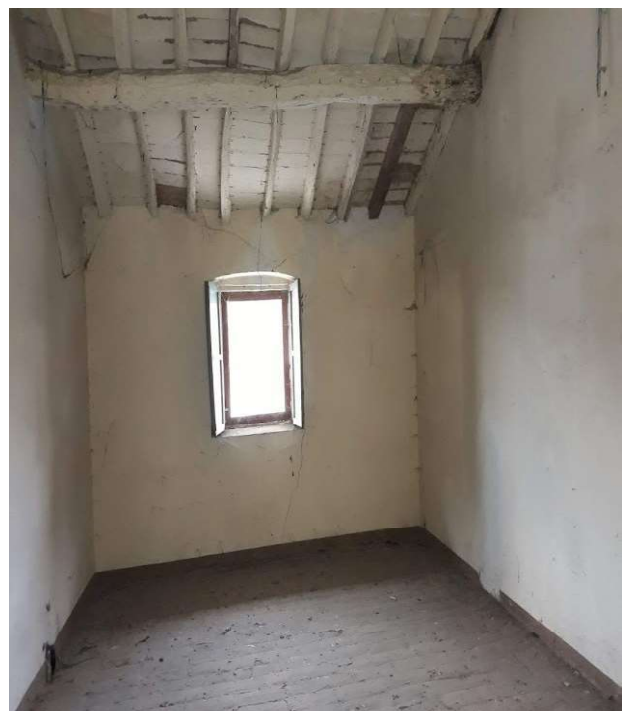
Locale al piano primo con particolare copertura
