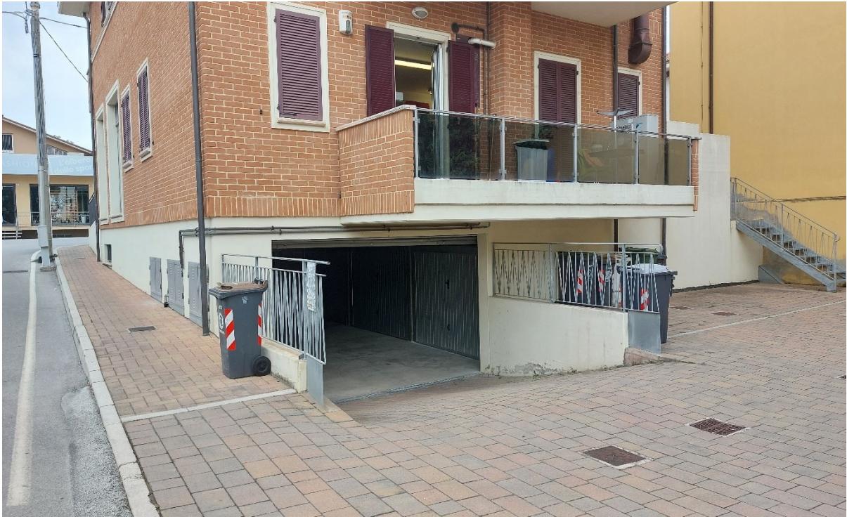
FOTO 1 – ESTERNO DEL FABBRICATO E ACCESSO AI GARAGE
