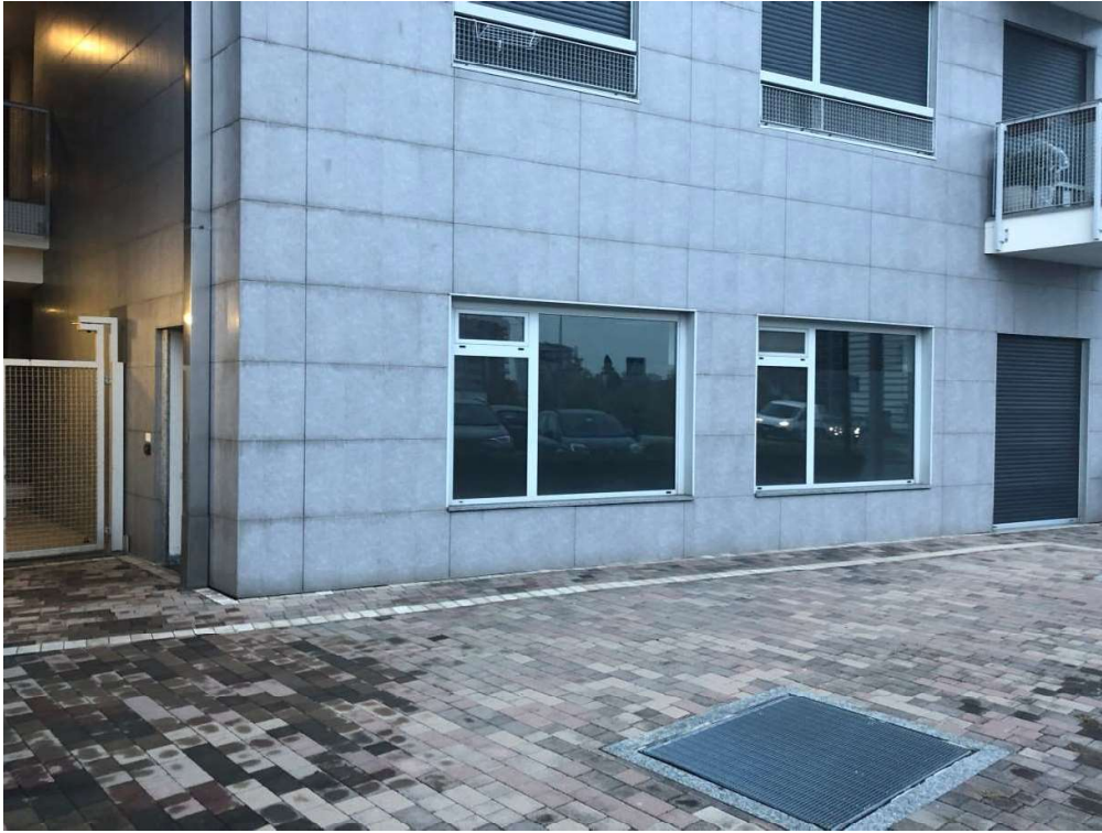
Vista ingresso pedonale da via Alessandro Volta
