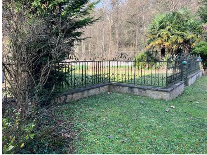
Esempio Recinzioni interne e esterne / opere esterne non autorizzate-difforni
