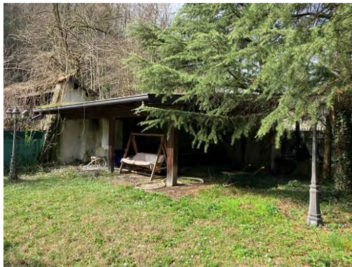
Tettoia non autorizzata
