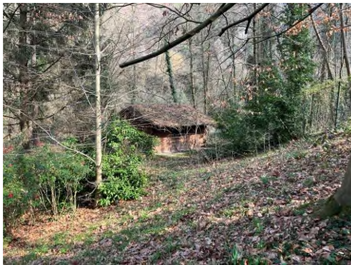
Edificio non autorizzato
