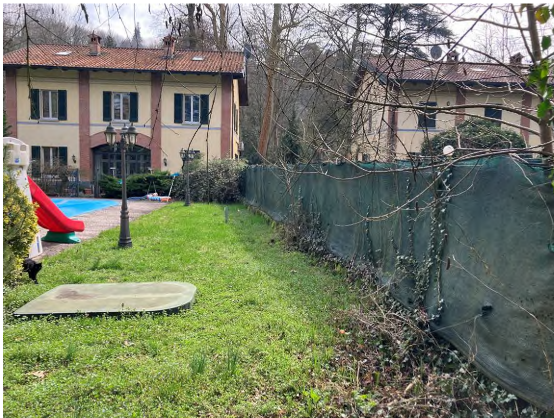
Vista fronte nord/ovest (nota: piscina e pavimentazioni non autorizzate)
