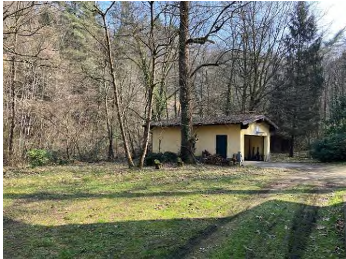
Edificio non autorizzato
