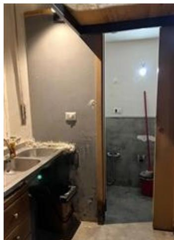
Dettaglio della parete tra wc e angolo cottura in cui si apprezzano la presenza di schiuma sigillante e le macchie sulla parete
