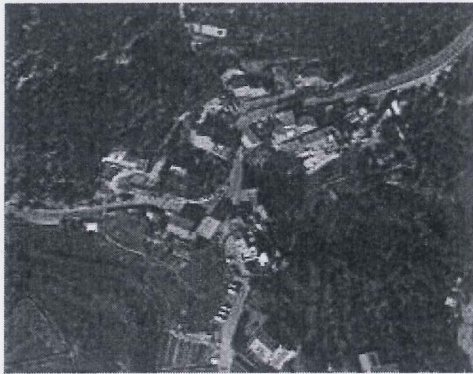
FOTO AEREA DELLA ZONA
